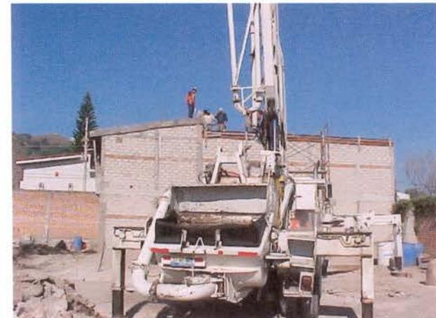
Colado de azotea, con concreto premezclado.
