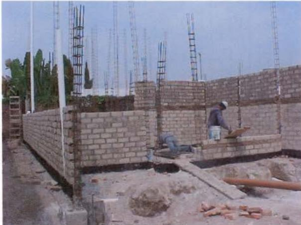
En esta imagen se aprecia el anclaje de castillos.
