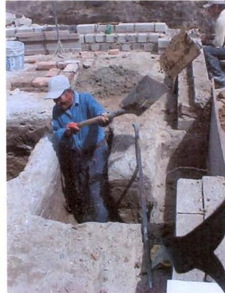
Fabricación de cimentación de suelo-cemento y zapatas aisladas, también se aprecia la nivelación de muro a teson.
