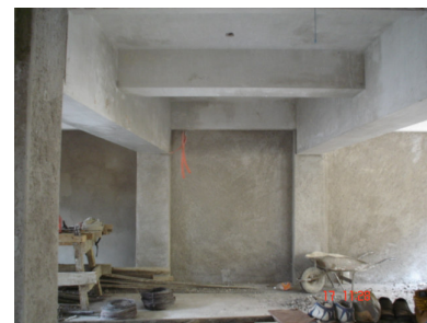
Aplanado fino de yeso y mortero en PB y fachada
