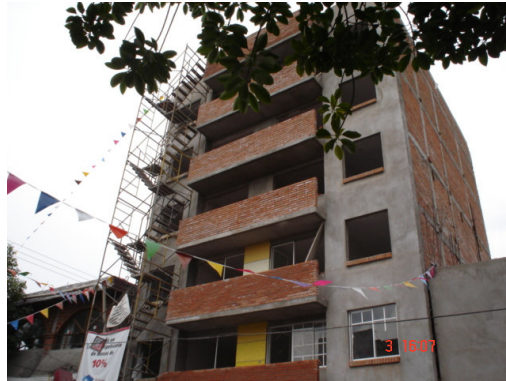
Detalle de balcones y pechos de paloma
