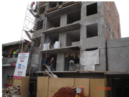
Aplanado fino de yeso y mortero en PB y fachada
