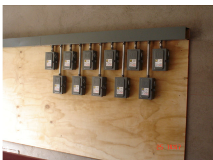
Ranurado y cableado de cada departamento, tablero de interruptores
