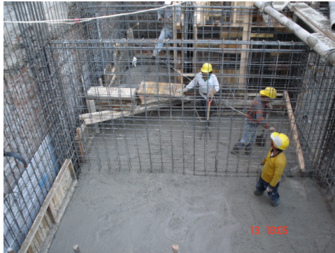
Colado losa fondo
