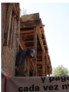
Colado de la losa de segundo nivel
