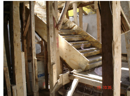
Detalles de cimbrado y colado de escalera
