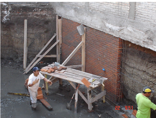
Excavación y recimentación
