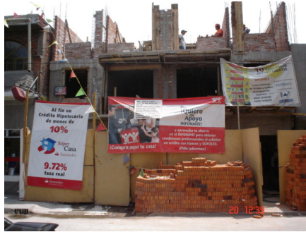
Fachada del edificio al terminar trabajos de albañilería de segundo nivel
