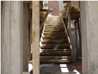
Detalles de cimbrado y colado de escalera
