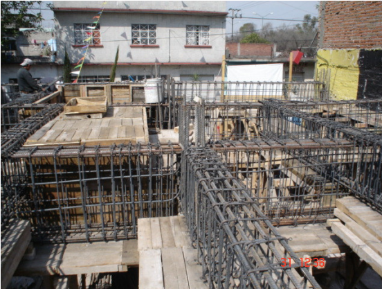
Armado de trabes y cimbrado de losa de primer nivel
