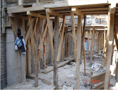
Columnas de P.B. y cimbra losa primer nivel
