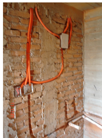
Ranurado y cableado de cada departamento, tablero de interruptores
