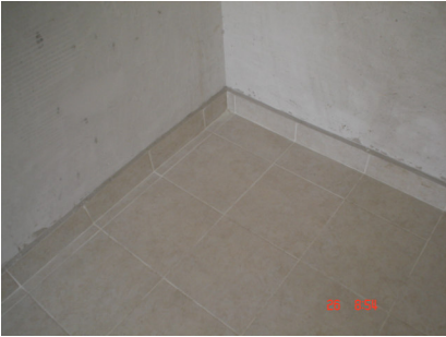
Detalles de piso y zoclo en cocina y estancia
