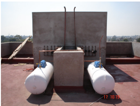
Conexión y alimentación de gas estacionario
