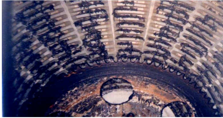
Figura 4. Biodiscos de la planta de tratamiento de Ciudad Universitaria
