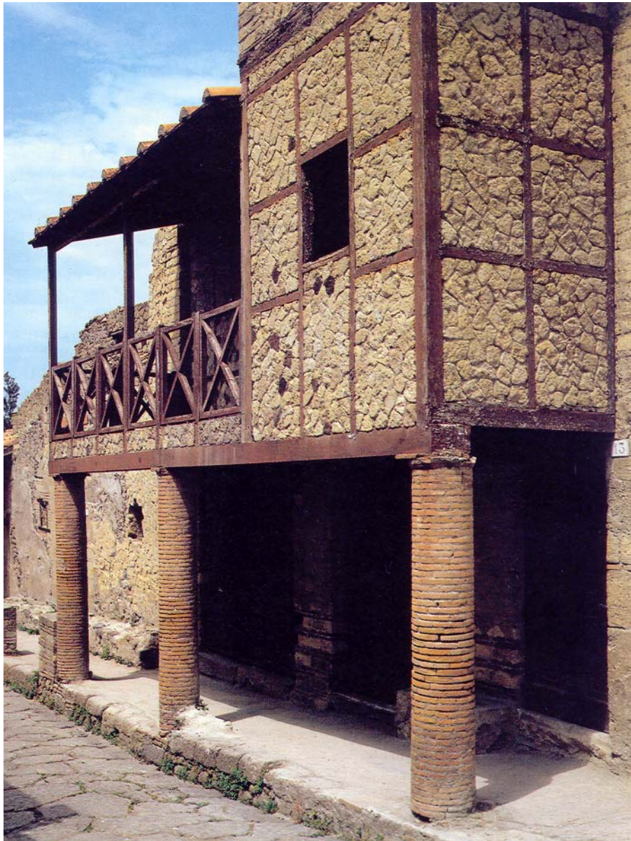
Fig. 6 Casa de Cañizo, con urdidura de madera y relleno de bloques irregulares Herculano
