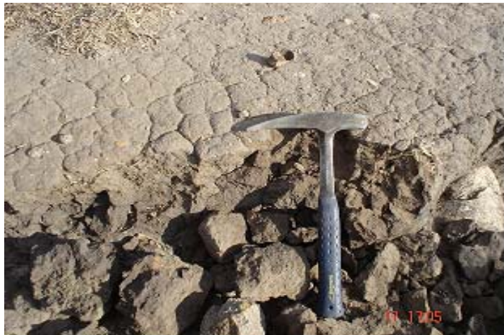
Fig. 19 Agrietamiento de forma poligonal de tepetates.
