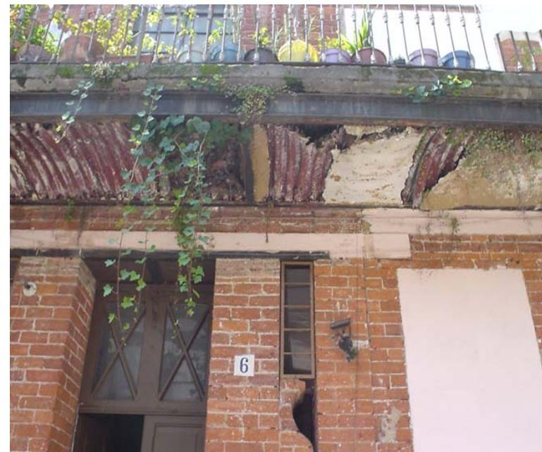
*Imagen 36. La falta de mantenimiento ha provocado el deterioro del pasillo en planta alta, corriendo el riesgo de desplomarse.*
