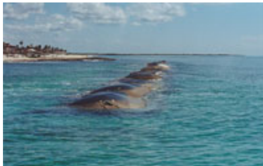
Figura 7-1 Geotubo funcionando como dique.
