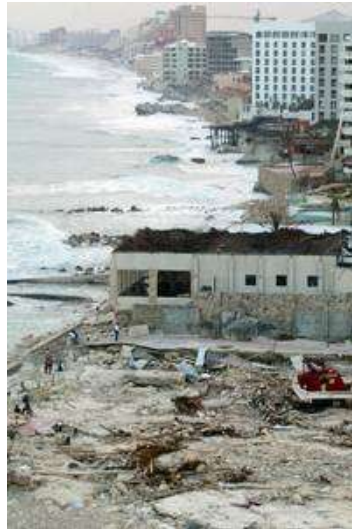
Figura 1-3 Zona hotelera después del paso de Wilma.
