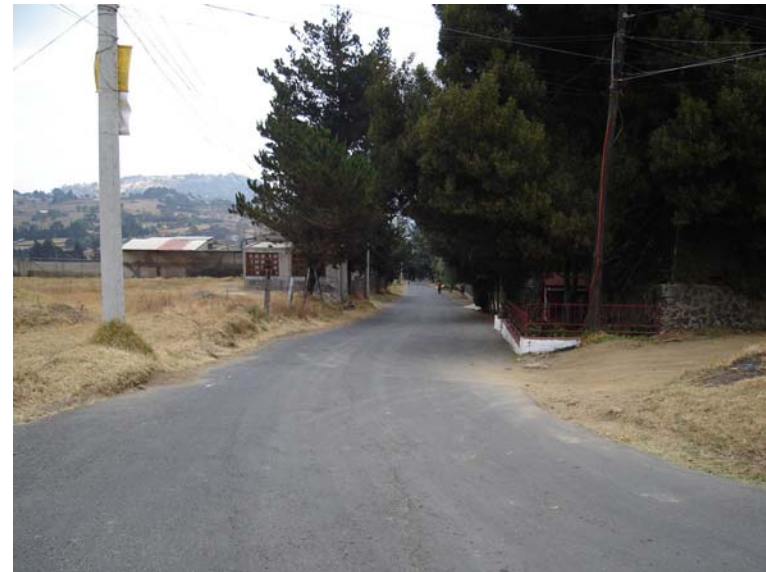
Foto 4. Cableado de teléfono y pavimento
