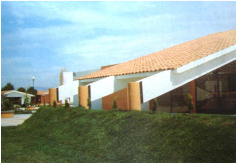
Foto 7. Taludes de tierra
