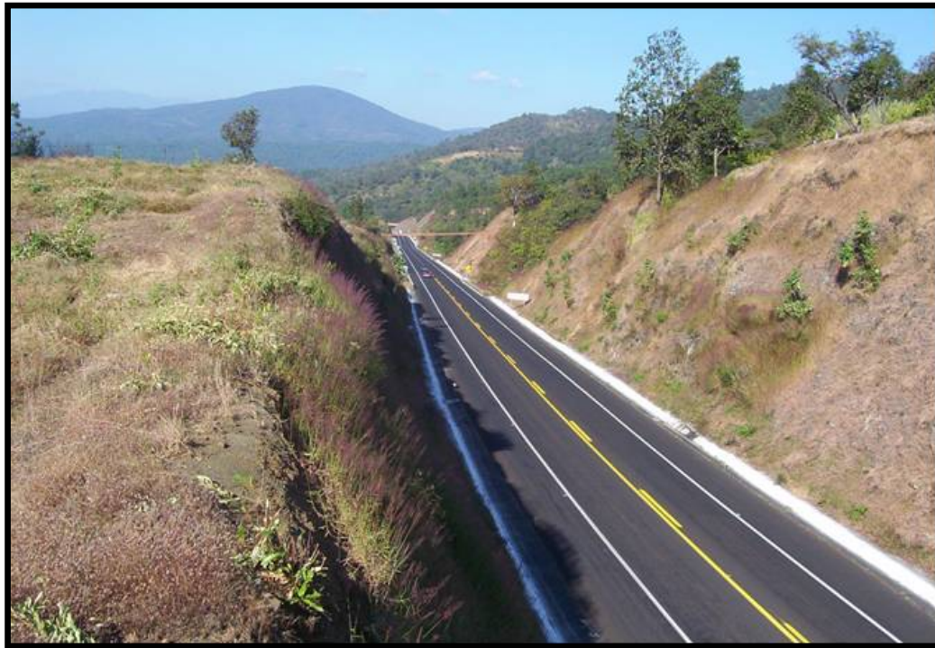
Foto No 10. Talud Artificial (Fuente: Propia).
