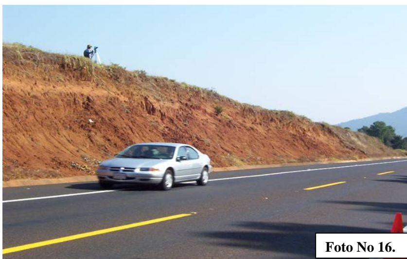
Foto No 16.- Realización del levantamiento topográfico, donde la semi-estación se ubica en frente de uno de los taludes en estudio.
