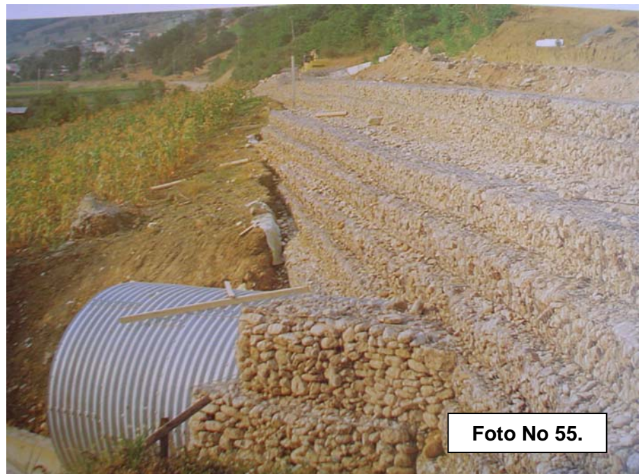
Foto No 55.- En esta imagen se ve la manera en que es contenido un terraplén utilizando muros gabión.
