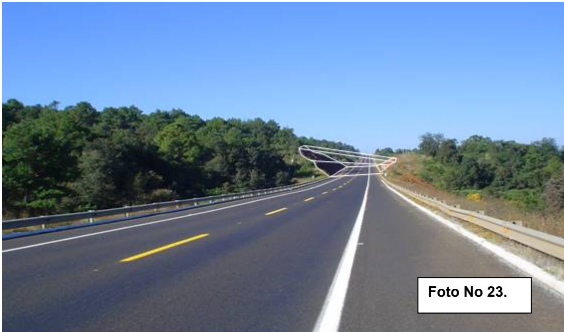
Foto No 23.- Vista panorámica del tramo Km. 62+070 al Km. 64+170 se observa en el lado derecho, bosque y el lado izquierdo poco bosque y de mucho menor altura del talud. Se trazó un esquema del volumen de material que se cortó para incorporar el cuerpo de la autopista. (Fuente: Propia)
