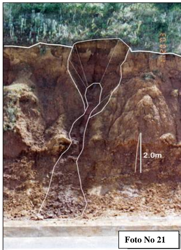
Fig. 3.4.- Tipología de procesos de remoción en masa que provocan la inestabilidad en los cuerpos de talud del Km. 62+070 al Km. 64+170. El proceso inicia a partir de un deslizamiento rotacional provocado por el empuje hidrostático de los flujos de agua, que al incrementar la humedad del cuerpo desprendido provoca una transformación de la tipología a flujo de lodo, que se deposita al pie del talud. Obsérvese en la figura la gran cantidad de flujo de lodo los cuales se encuentran asociados a escurrimientos subterráneos de agua. (Fuente: Propia).
