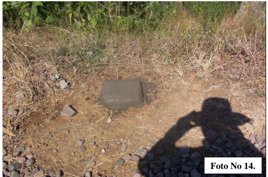
Foto No 14.- Aspecto de mojonera terminada, para fijación de banco de nivel.
