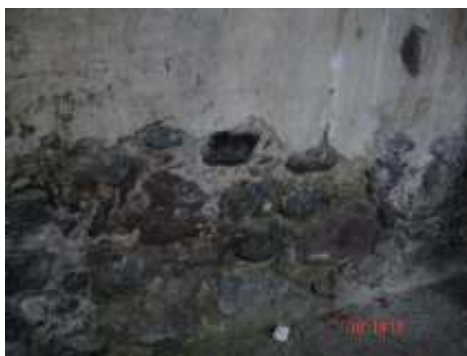
F.9. Muros en planta baja
