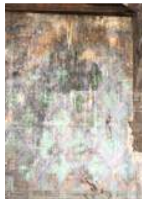
F.11. Detalle de pintura en muros interiores
