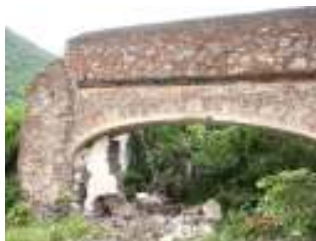
F.21. Detalle de ripiado
