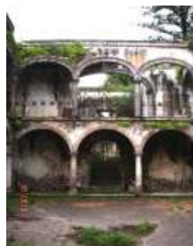
F.10. Arcada perimetral en patio central
