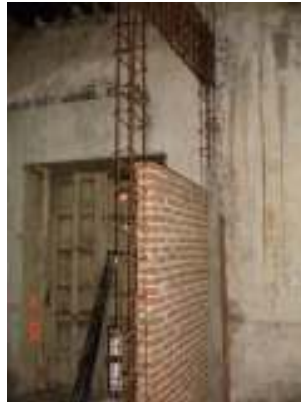
F.16. Muros levantados
