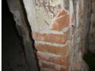
F.12. Muros en planta alta
