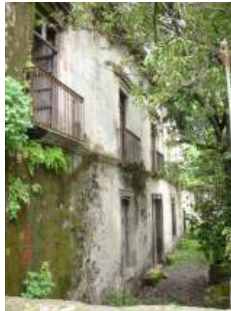
F.8. Fachada principal.
