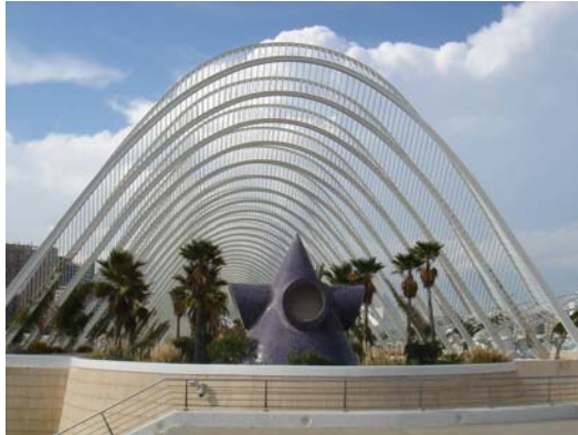
22. Realizada en su totalidad de acero, la cubierta del estacionamiento en la ciudad de las artes, Valencia, España.
