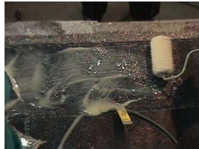
34. Vista de la colocación de las fibras de carbono, que sustituyen al acero, en el apoyo intermedio de un puente.
