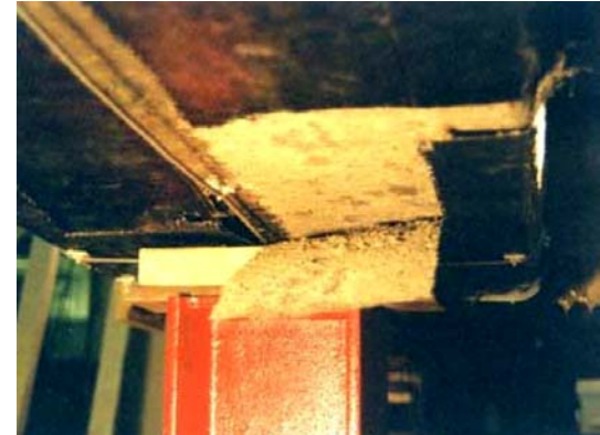
34. Vista de la fractura de las fibras de carbono, provocado por un exceso de carga, en pruebas realizadas en laboratorio.
