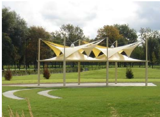
20. Velaria de fibras sintéticas formando una cubierta con paraboloides hiperbólicos, Glasgow, Escocia.
