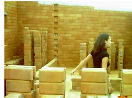
20. Habitación elaborada con bloques maquinados con una porción de cemento común, Coahuila, México.
