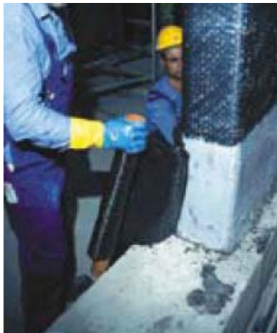
34. Vista de la colocación de las fibras de carbono, que sustituyen al acero, en el apoyo intermedio de un puente.
