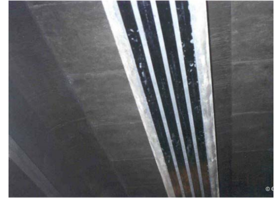
18. Viga de concreto armado reforzada longitudinalmente por el aumento en la carga estática, con cinta de fibra de carbono, Madrid, España.
