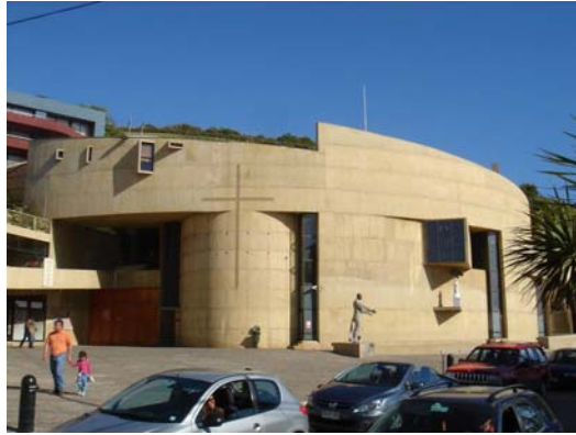
20. Iglesia realizada en su totalidad con concreto, con refuerzo de acero, Viña del Mar, Chile.
