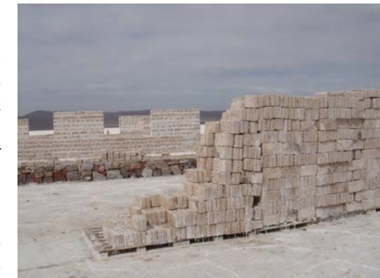
34. Bloques apilados a un costado de una edificación de muros de sal, cerca de donde fueron extraídos y que en poco tiempo se volverán a formar, Salinas Grandes, Argentina.
