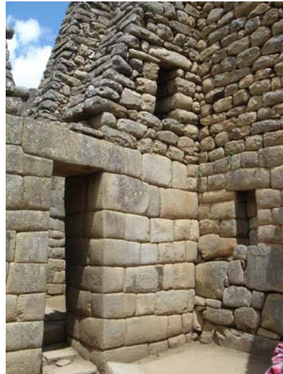
14. En la cultura inca como en otras se encuentran rocas labradas y piedras ensambladas casi de manera perfecta, Machu Pichu, Perú.
