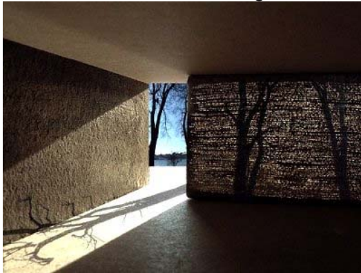
34. Muro de concreto translucido en una vivienda de Hunarí. foto: Áron Losonzi.
