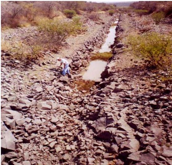
**Fotografía 3.26** Canal excavado en Basalto (TmA-B) entre las presas vieja y nueva de Jalpa, 10 Km. al SW de Manuel Doblado.
