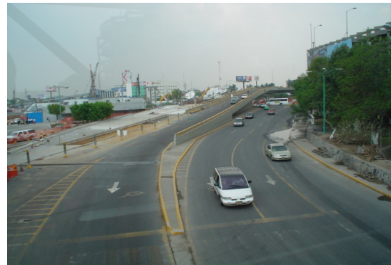
...Foto 5.- Acceso al terreno por calle Aeropuerto Civil
