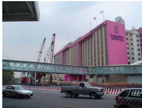
Foto 15.- Puente peatonal hacia el Hotel Camino Real
