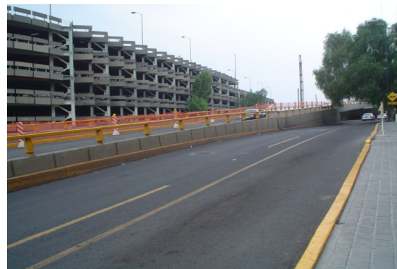
Foto 7.- Calle Puerto México
