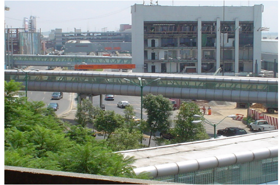
Foto 14. Puente hacia el estacionamiento de pilotos
