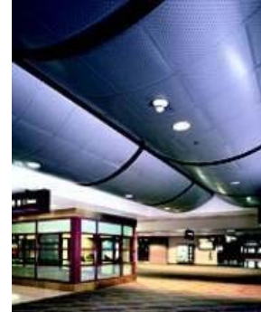
Foto 39. Plafón marca USG Yeso modelo Curvatura
