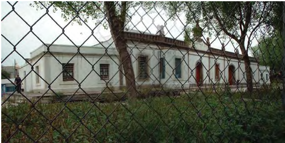
IMAGEN 45.- VISTA FACHADA DE EDIFICIO ESTACION DE FERROCARRILES
