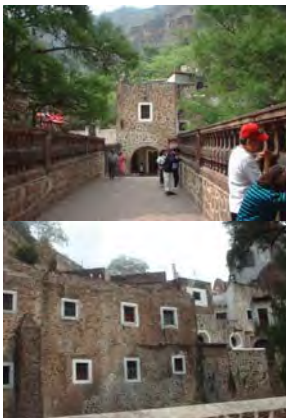
IMAGEN 50.- CAMINO EN LA PARTE POSTERIOR DE LA SACRISTÍA IMAGEN 51.- FACHADA SACRISTÍA , EN SU PARTE INFERIOR UN ARCO QUE LIBRA UN CLARO Y SOBRE EL CUAL DESCANSA LA MISMA. IMAGEN 52.- SALIDA DE LA SACRISTÍA POR MEDIO DE ESTE PUENTE SE CRUZA EL RIO, AL FONDO CONSTRUCCIONES RECIENTES DE COMERCIOS ARTICULOS RELIGIOSOS IMAGEN 53.- FACHADA DEL CONVENTO VISTA DESDE UNO DE LOS LADOS DEL RIO.
