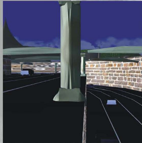
Diferencia de niveles en los carriles de Guadalupe
