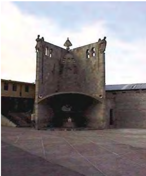
IMAGEN.- 27, CONSTRUCCIÓN REALIZADA PARA EL POCITO www.redial.com.mx/sanjuan/ubicación.html
