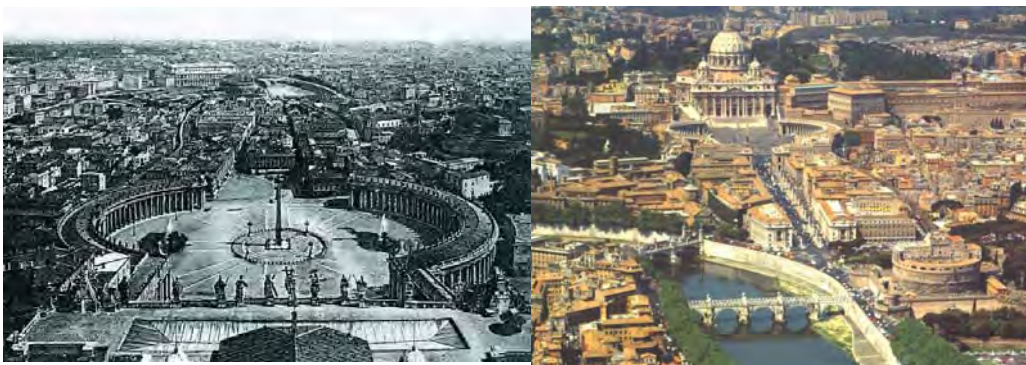
IMAGEN 114.- PARTE POSTERIOR ÁBSIDE DEL TEMPLO DE SN PEDRO, SE PERCIBE LA PLANTA DE CRUZ GRIEGA. FUENTE: MURRAY RENAISSANCE ARCHITECTURE PAG.101
