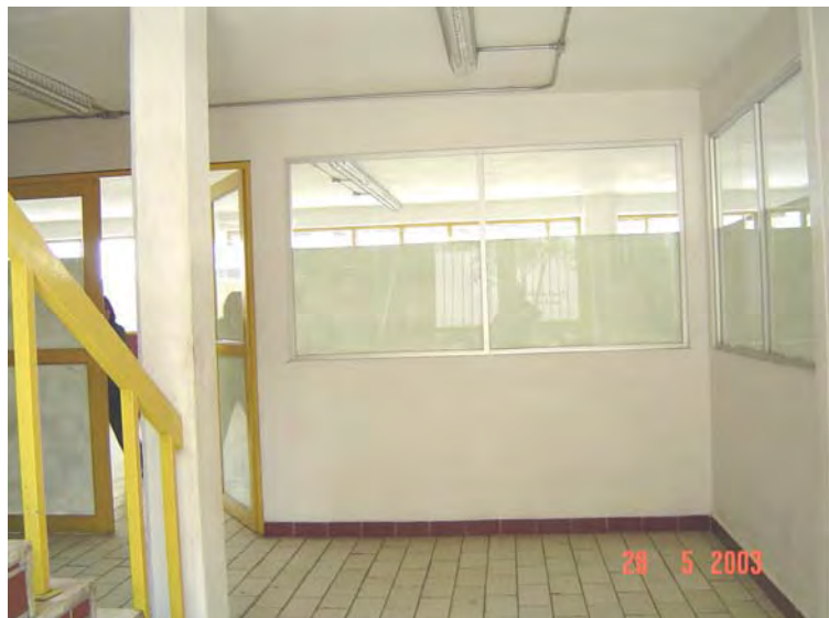
IMAGEN 4.-VESTÍBULO EN UNO DE LOS DORMITORIOS EN DONDE SE HALLA LA ESCALERA, Y EN PLANTA ALTA LOS DORMITORIOS PARA MUJERES, TOMADA EL 28 DE MAYO DE 2003
