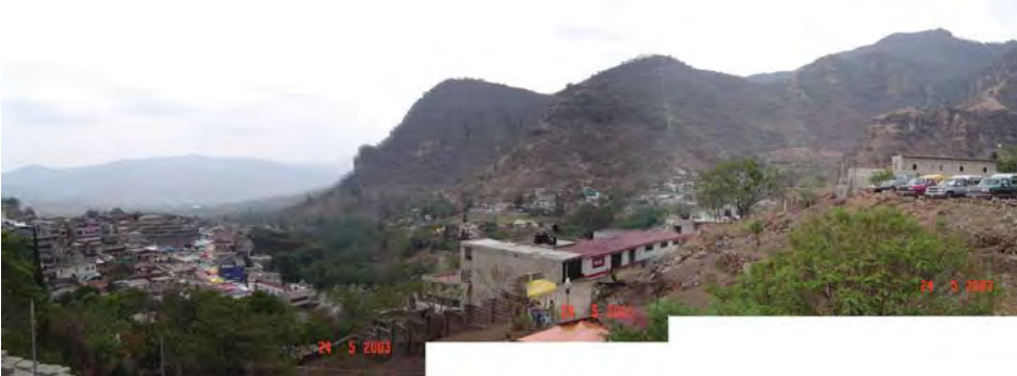
IMAGEN.-15 PUEBLO DE CHALMA DESDE LA PARTE SUPERIOR, SE OBSERVA COMO SE RODEA POR CERROS, Y LA FACTURA RECIENTE DE ESTE. TOMADA EL 24 DE MAY. DE 2003
