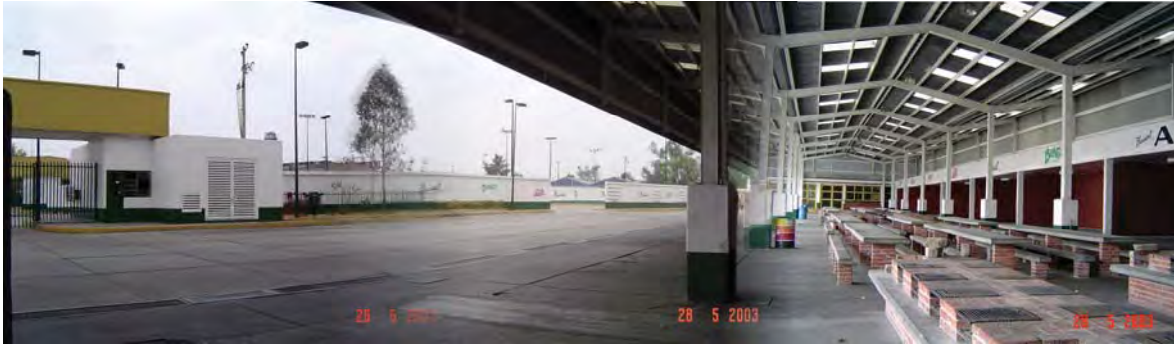
IMAGEN 8.-ÁREA DE COMEDOR, SE OBSERVAN LAS MESAS Y ANAFRES SON FIJOS, CONSTRUIDOS DE CONCRETO Y TABIQUE, ESTE TIENE UNA CAPACIDAD PARA 1200 PERSONAS, TOMADA EL 28 DE MAYO DE 2003.
