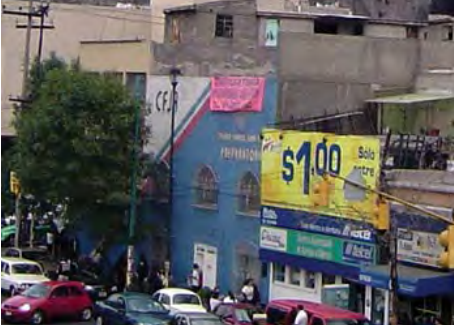
IMAGEN 35.- ESCUELA PREPRIMARIA Y PRIMARIA PRIVADAS SOBRE CALZ. DE MISTERIOS EN INMUEBLE HISTÓRICO MUY BIEN CONSERVADO
