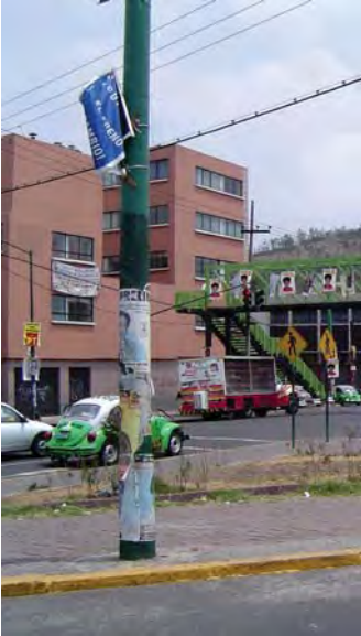
IMAGEN 38.- ACERA PONIENTE DE LA AV. 5 DE FEBRERO CLINICA PARTICULAR EN BUEN ESTADO DE CONSERVACIÓN
