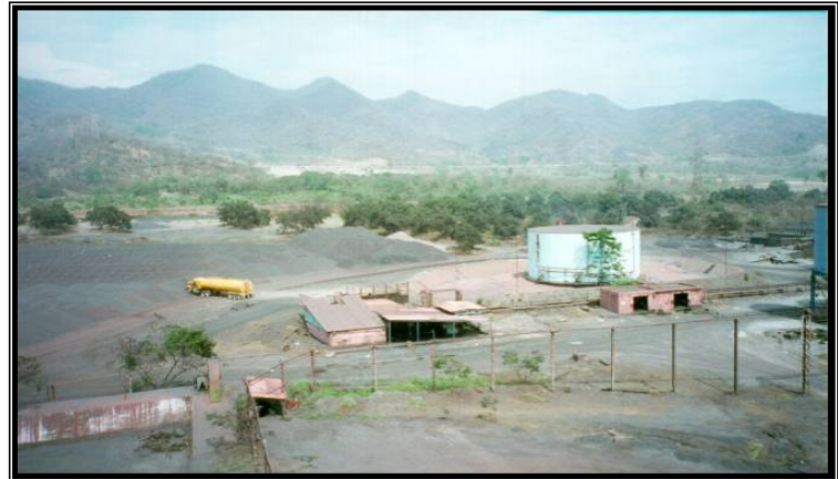
Figura 9. Fosa de recepción de combustóleo, tanque de almacenamiento y casa de bombas
