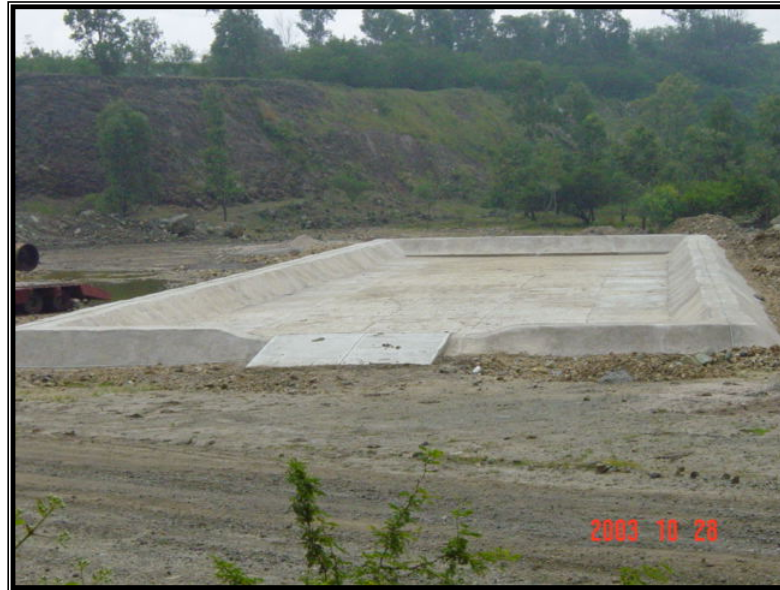
Figura 48. Celda terminada con la base de concreto y el bordo perimetral con revestimiento de cemento
