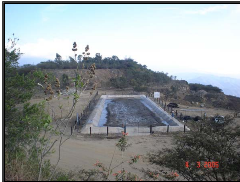
Figura 49. Vista panorámica con los tanques de almacenamiento de lodos y la cerca de alambre
