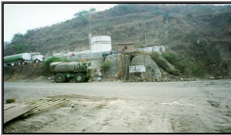
Figura 6. Estación para cargar diesel en el taller La Encantada
