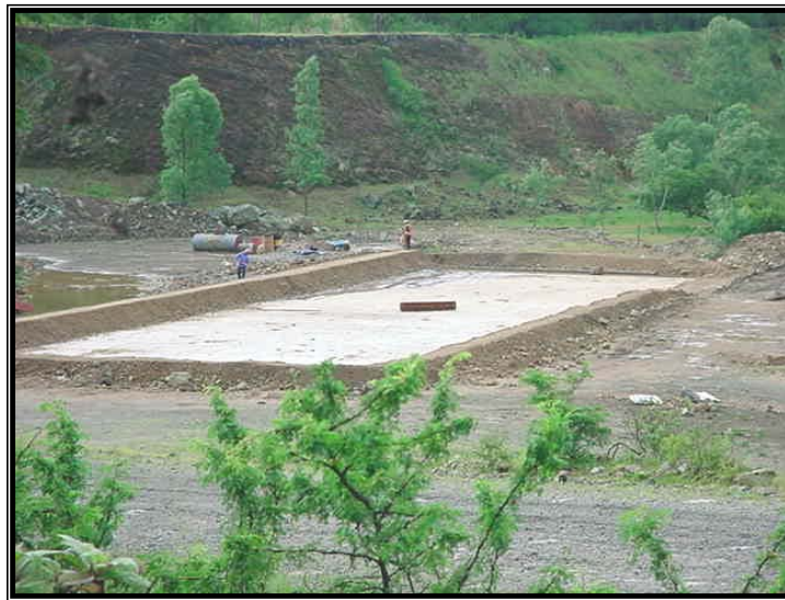
Figura 47. Capa de arcilla y bordo perimetral de la celda de tratamiento
