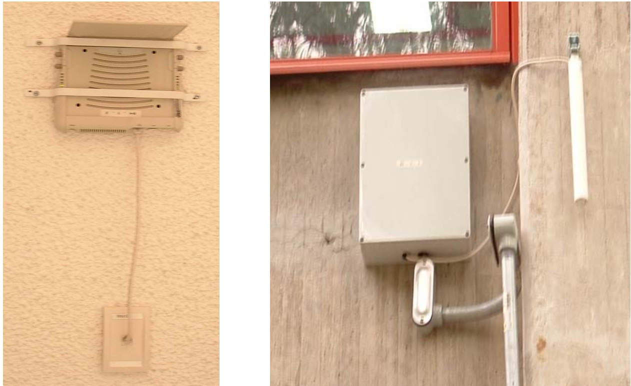
Figura 4.2 Colocación de un punto de acceso.
