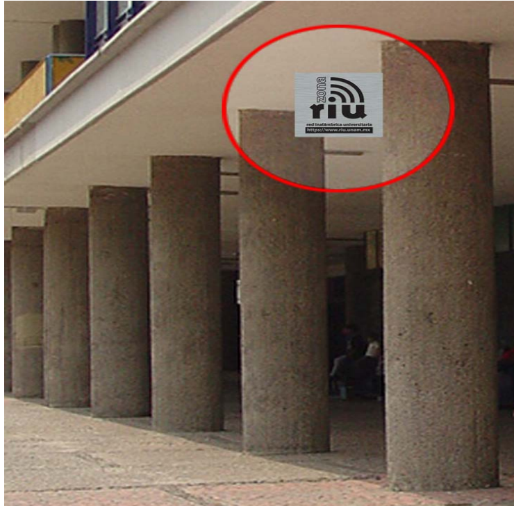
Figura 4.3 Señalización de la RIU.
