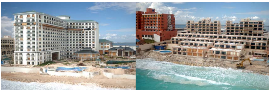
Figura 5. 31. Daño a las estructuras de los Hoteles (CFE)
