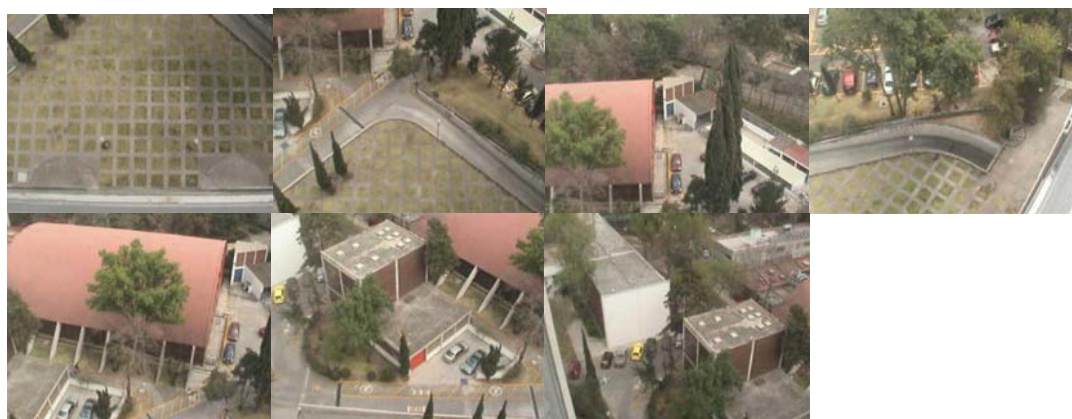
Figura 5. 11. Imágenes tomadas desde el techo de la Torre de Ingeniería
