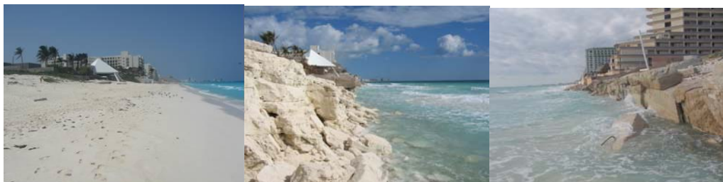
Figura 5. 30. (a)Antes del Huracán Wilma, (b) Después del Huracán Wilma, (c) Ubicación del Hotel Cancún Palace después de que pasó el Huracán Wilma
