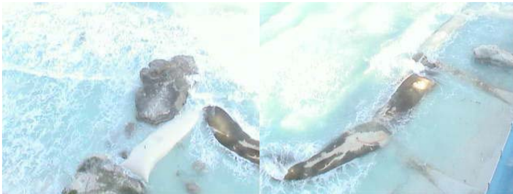
Figura 1. 8. Reflexión del oleaje debido a la presencia de bolsacretos
