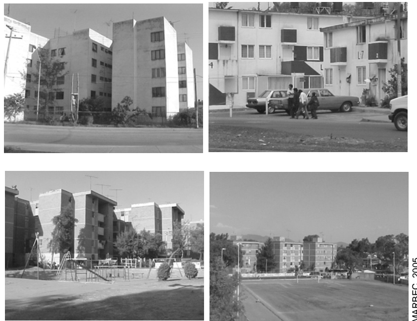
Fotos 17-20. INFONAVIT. En la parte superior tipo de viviendas del fraccionamiento Cuautitlán Izcalli Zona Norte. En la parte inferior, edificios del Plan Maestro Noroeste
