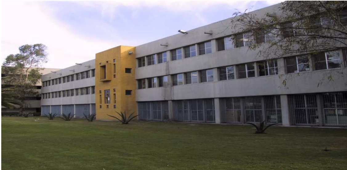
Edificio 74 de la unidad Xochimilco de la Universidad Autónoma Metropolitana, fotografía del Arq. Luis Antonio Torres B. 2001.
