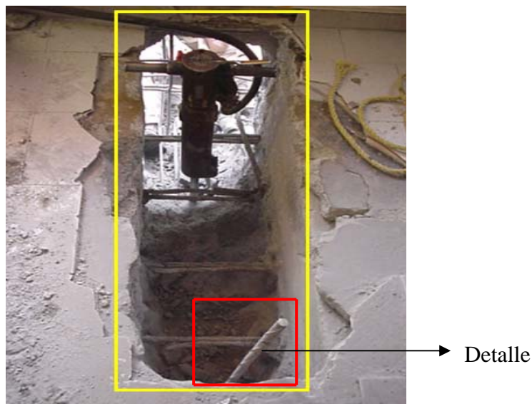
Fotografía 17. Zanja para anclaje de trabe TC-1 a losa y trabe de cimentación existentes.
