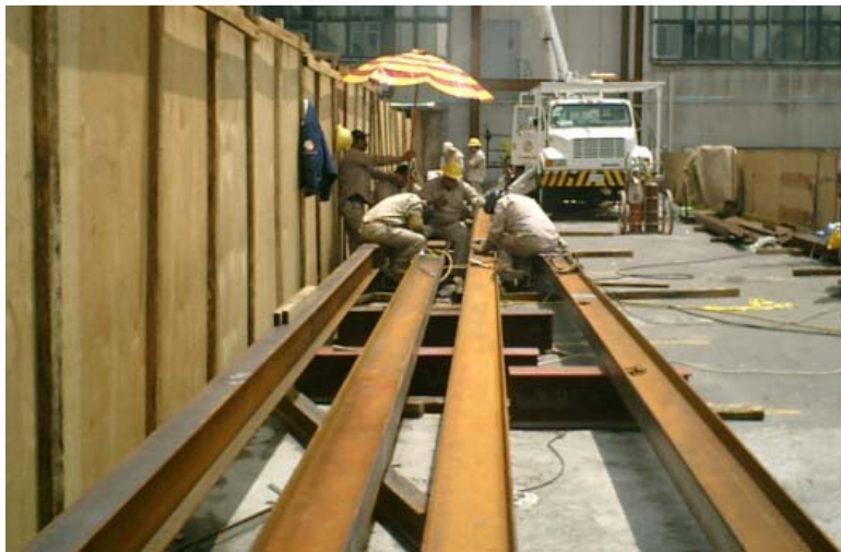
Fotografía 33. Suministro de estructura metálica al conjunto Verónica
