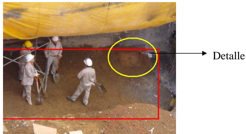
Fotografía 19. Colocación de capa de arcilla para mejorar el terreno de cimentación. El detalle enmarcado en la elipse se trata del pozo de visita que fue sellado durante la colocación de plantilla.
