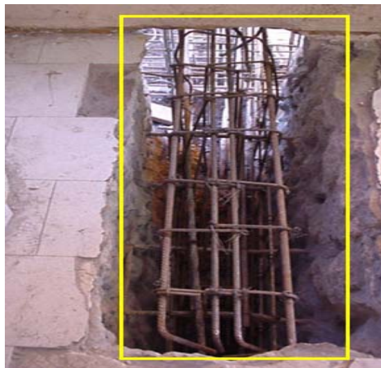
Fotografía 23. Anclaje de trabe TC-1 con losa de cimentación.
