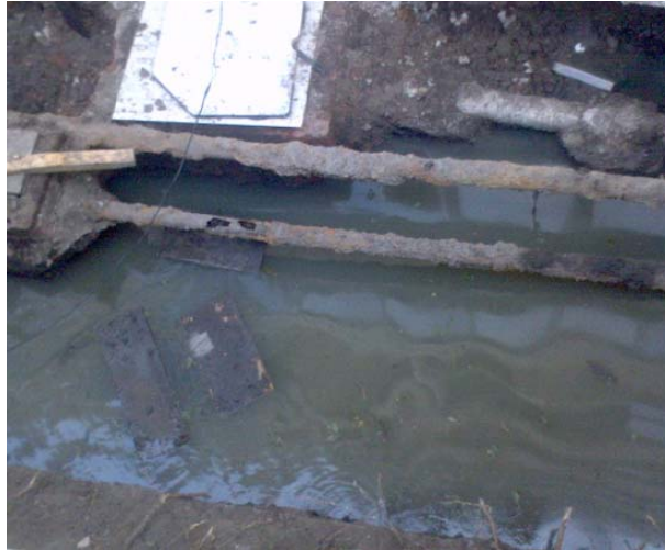
Fotografía 12. Presencia del nivel de aguas freáticas a 60 centímetros de profundidad en el área de excavación del edificio “B”.
