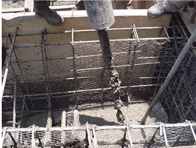
Fotografía 27. Colado y vibrado de los elementos en la cimentación del cuerpo “A”.
