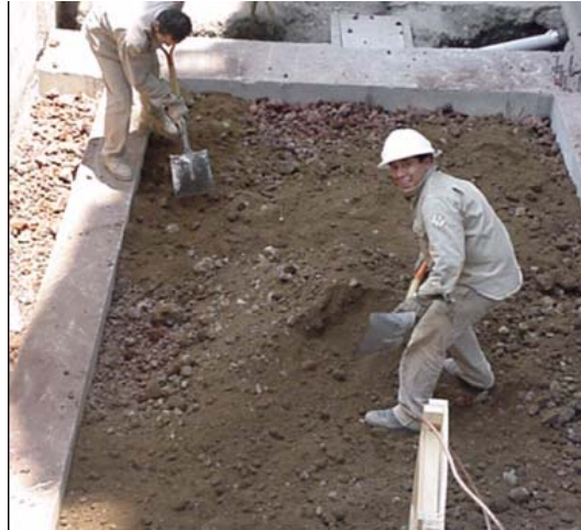
Fotografía 29. Labores de relleno en la cimentación.
