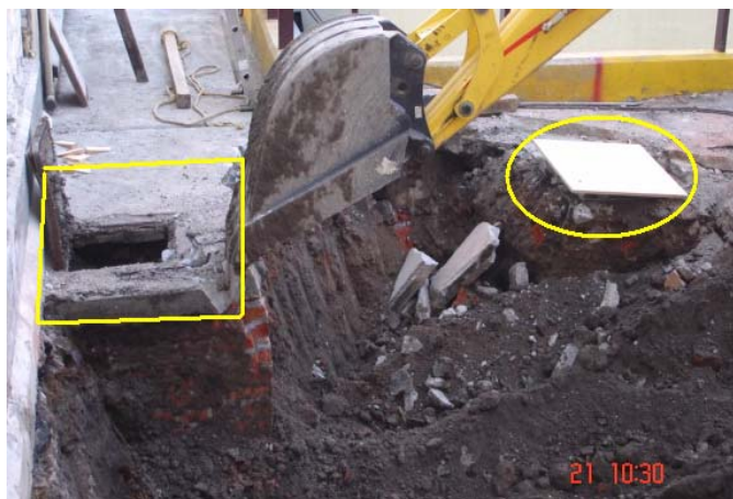
Fotografía 9. Se muestra en el cuadro la presencia del pozo de visita que fue demolido y sellado, la elipse por su parte encierra al registro eléctrico que también fue demolido.
