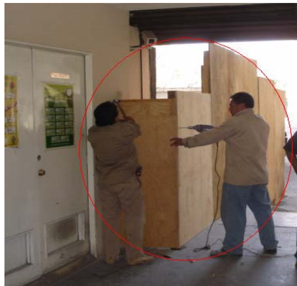
Fotografía 2. Colocación de tapial en la cara norte del desembarque de la torres de escaleras edificio “A”.
