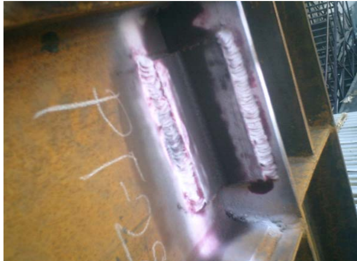
Fotografía 39. Prueba de líquidos penetrantes aplicadas a las placas de conexión trabe-columna.
