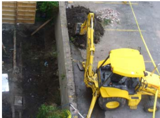
Fotografía 11. Trabajos de excavación ejecutados con retroexcavadora.
