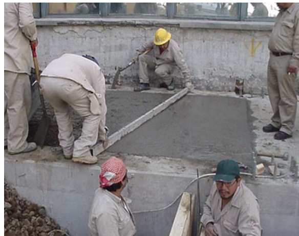
Fotografía 30. Colocación de firme de concreto.
