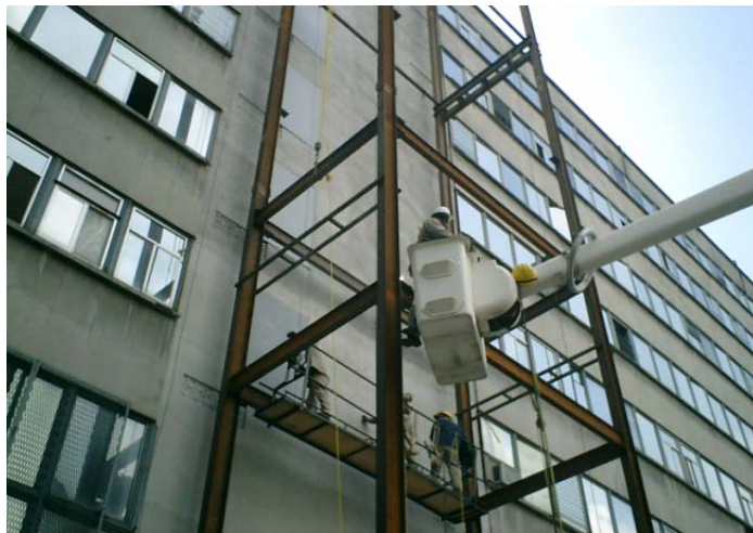
Fotografía 37. Montaje de las traveses que constituyen los niveles intermedios de la torre de escaleras del edificio “A”.
