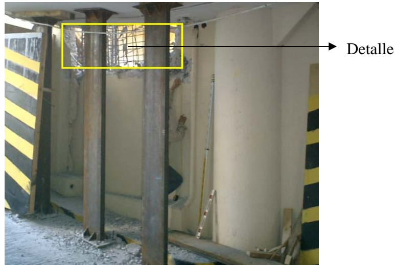
Fotografía 15. Apuntalamiento bajo la losa de rampa vehicular que se realizo con perfiles de acero estructural, el detalle encerrado en el rectángulo muestra el cuerpo demolido del muro interior de rampa.
