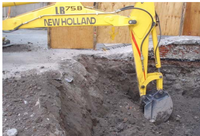
Fotografía 8. Excavación realizada con retroexcavadora.
