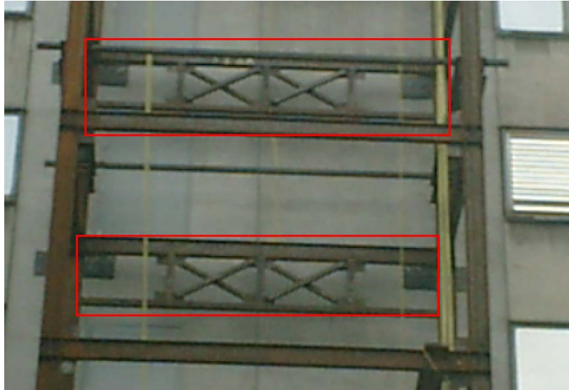
Fotografía 40. Montaje de contraventeos CV-2.
