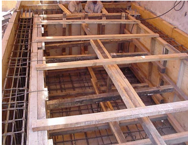
Fotografía 25. Trabajos de cimbra terminados, en ambos cuerpos el cimbrado fue similar.
