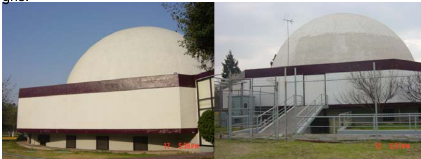
Vistas poniente y oriente.
