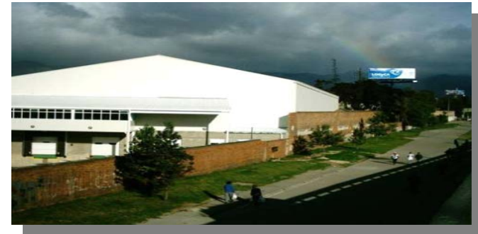
Vista hacia el interior del terreno, se observa una fábrica la cual se derrumbara.
