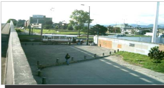
Estado actual en el cruce de Av. El Dorado y Boyacá
