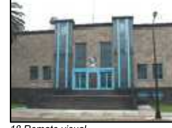
18 Remate visual Edificio de las "Bombas"
