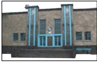
Edificio de las "Bombas".
