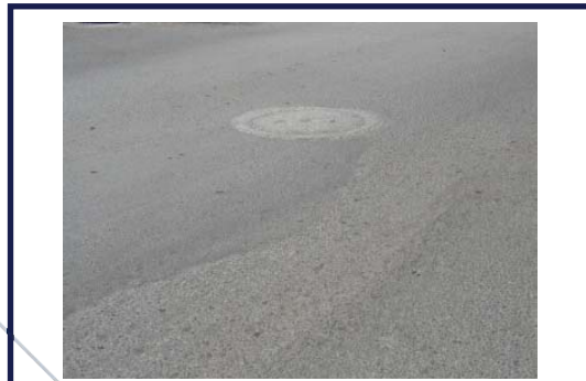
FOTOGRAFIA 23: VISTA DEL ALCANTARILLADO (RED PUBLICA DE DRENAJE)
