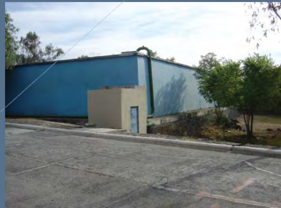
Cisterna de rebombeo.
