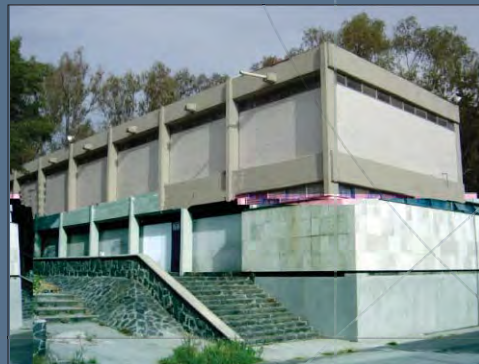
Vista Lateral Edificio de la SIMD
