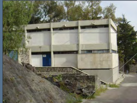
Vista Lateral Edificio de la SIMD
