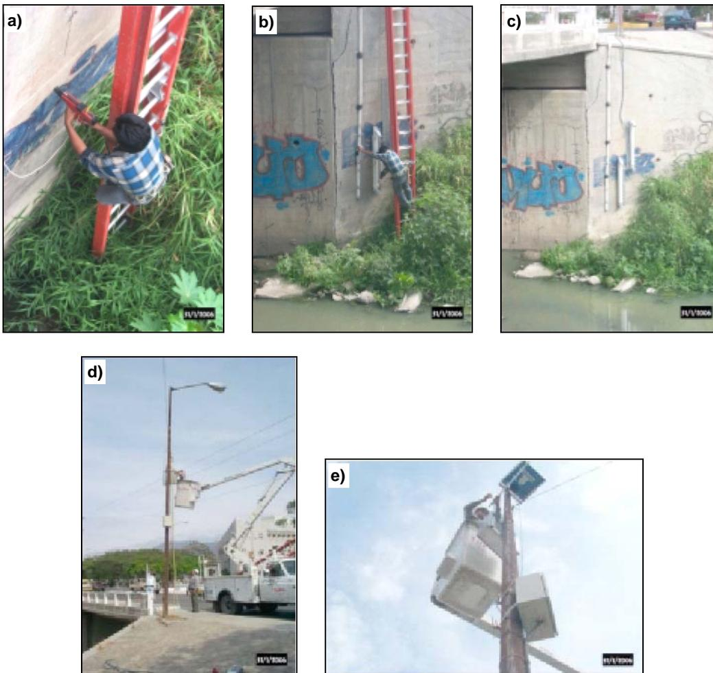
**Figura 6.19 Instrumentación de las estaciones hidrométricas**
