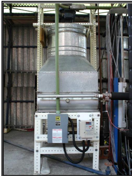
**Figura 7.2.5 Instalación del variador de frecuencia al motor del condensador enfriado con aire.**
