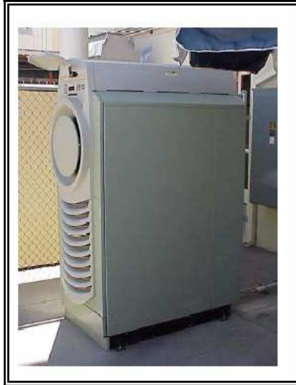
Figura 4.3. MTG Capstone de 30 kW.
