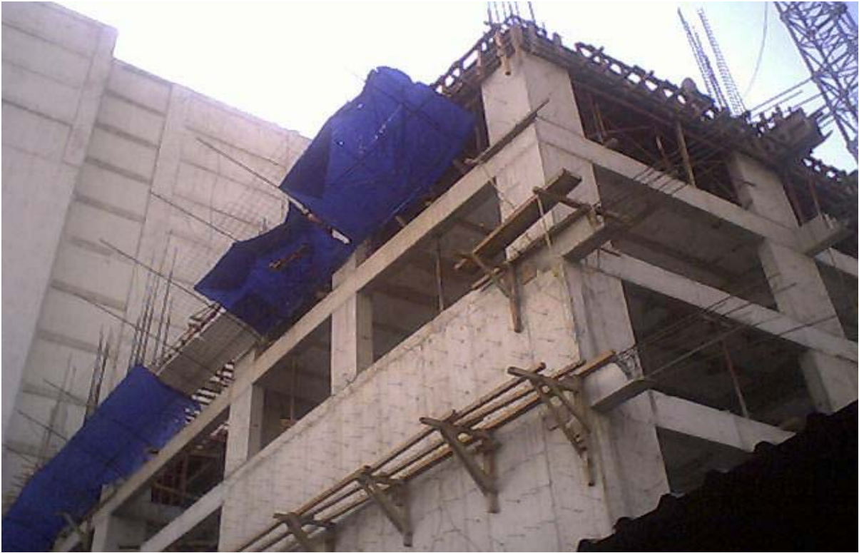
En la Fig. 4.3 Se muestra la protección colocada a las colindancias.
