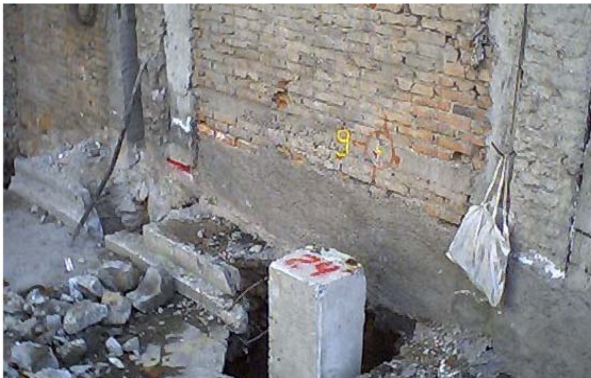
En la Fig. 2.10. Se muestra la fotografía el pilote hincado en su posición según proyecto.
