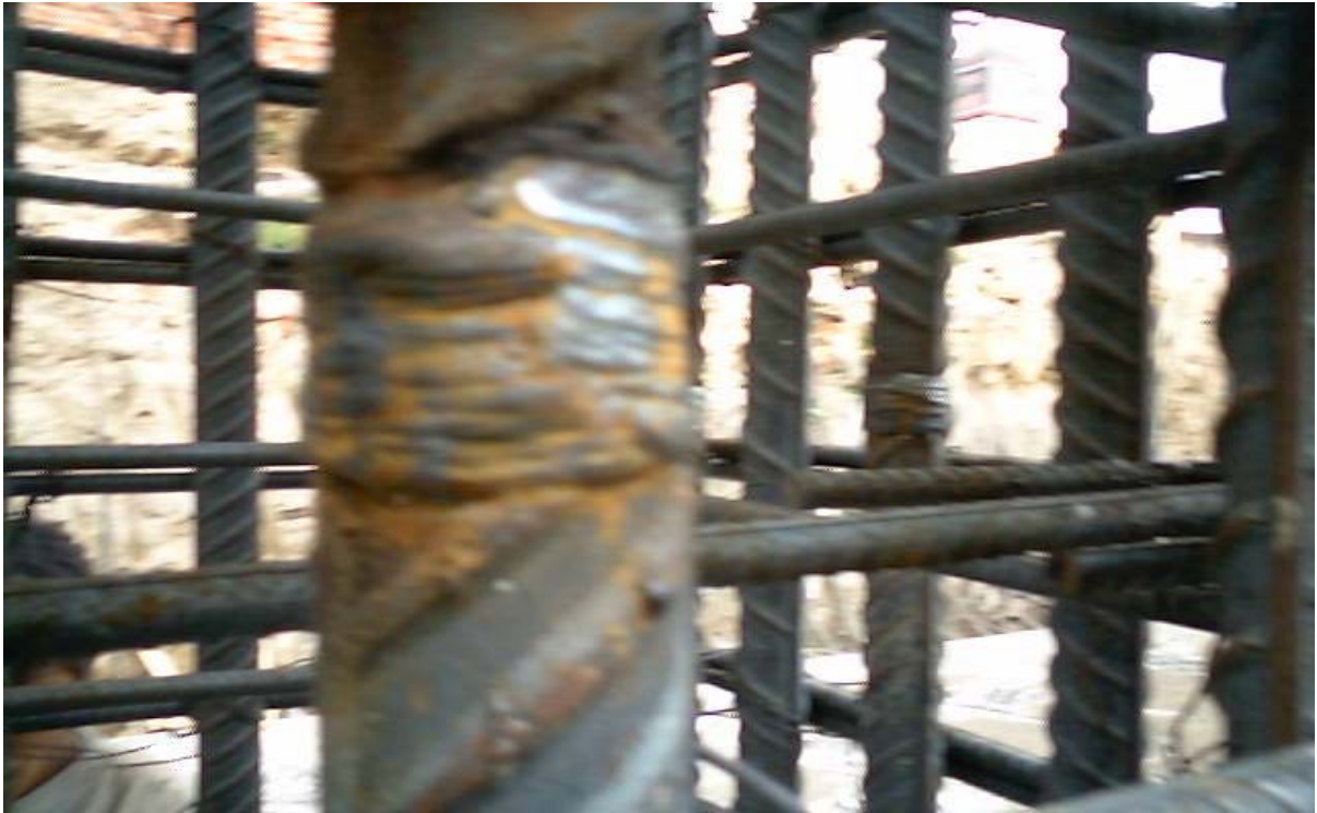
En la Fig. 3.5. Se muestra los bulbos en la varilla de las columnas.
