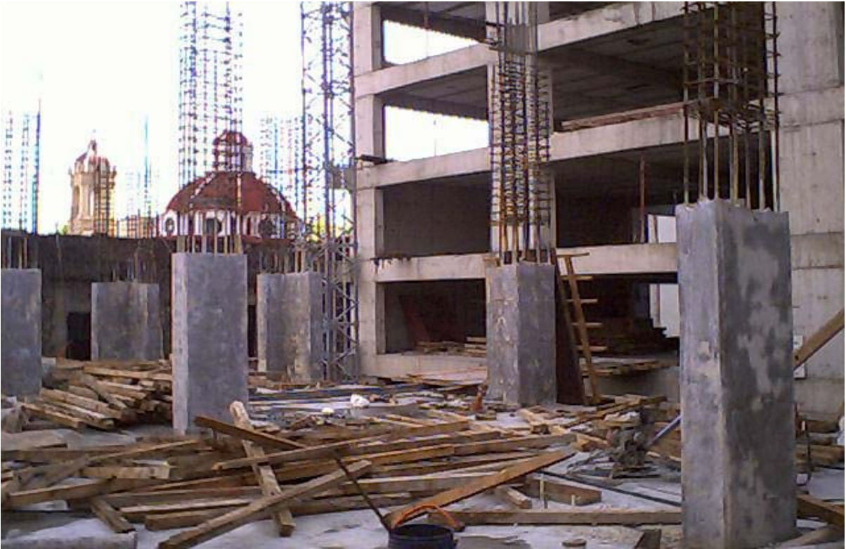
En la Fig. 3.7. Se muestra el curado de las columnas.
