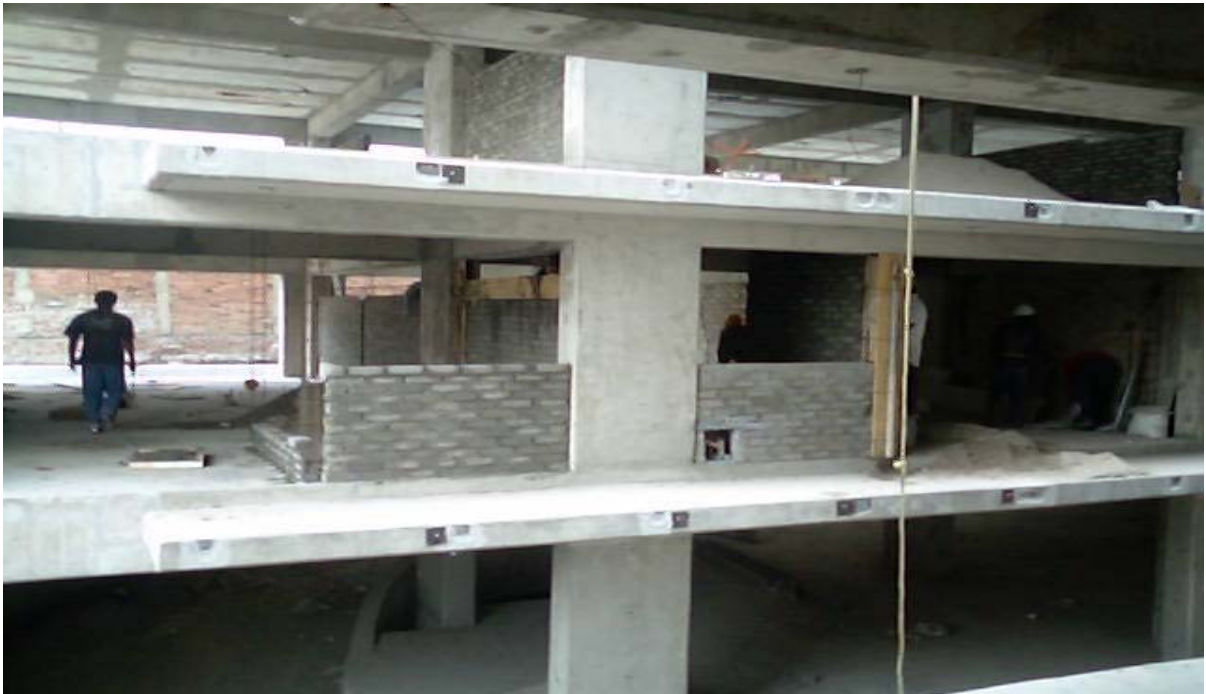
En la Fig. 3.11. Se muestra la construcción de los muros de tabicón ligero.
