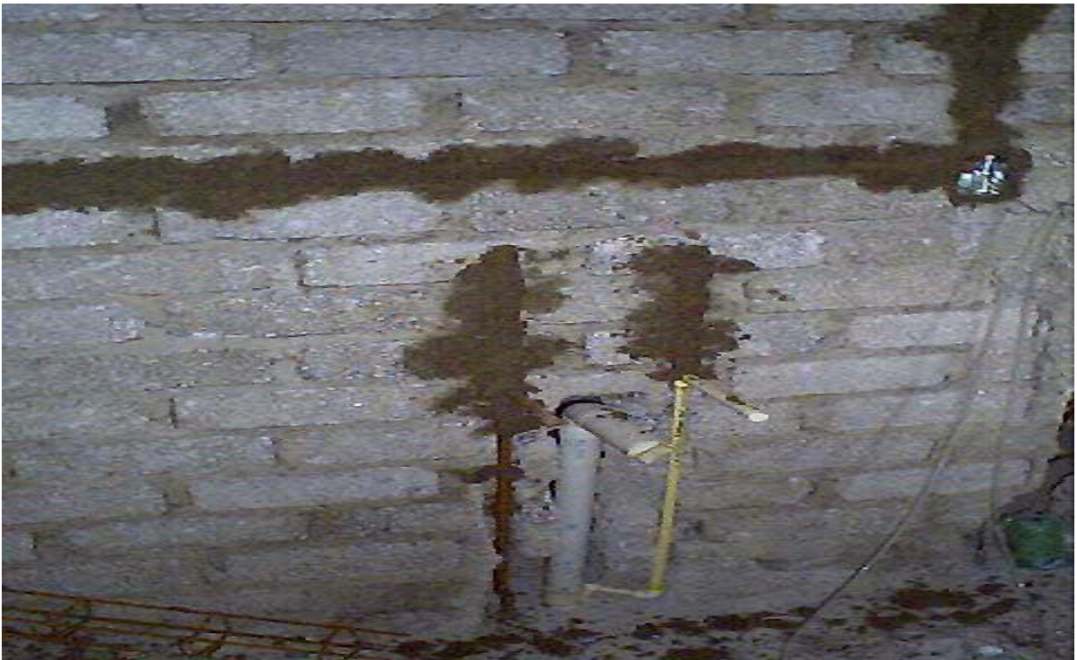
En la Fig. 3.10. Se muestra la colocación de la tubería para la instalación hidráulica.
