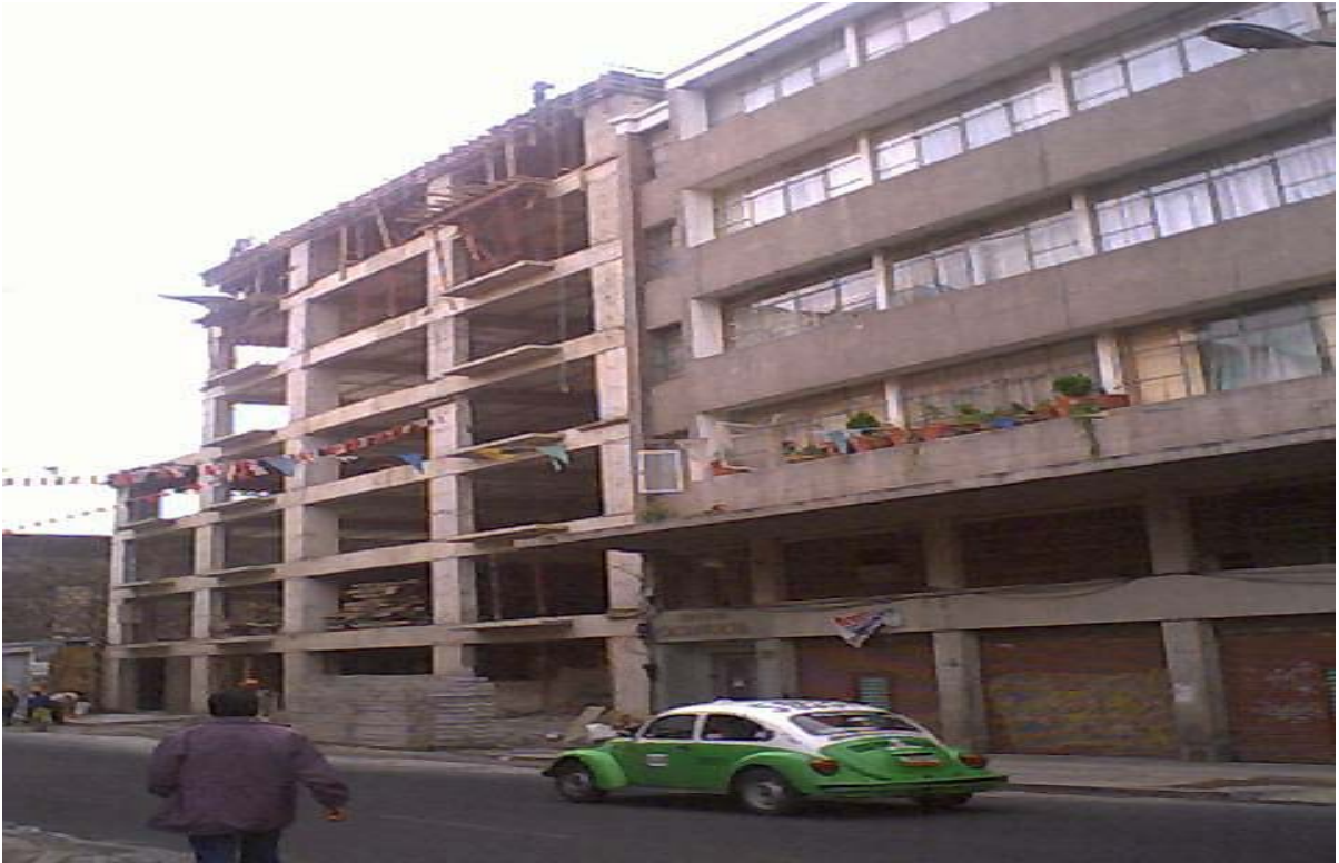
En la figura 5.7 se muestra el edificio C, en la etapa de construcción de estructura.
