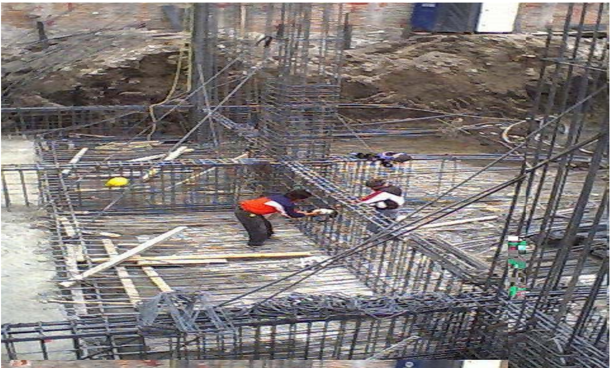
En la Fig. 3.1 Se muestra el armado de la losa de cimentación y las contratraves.
