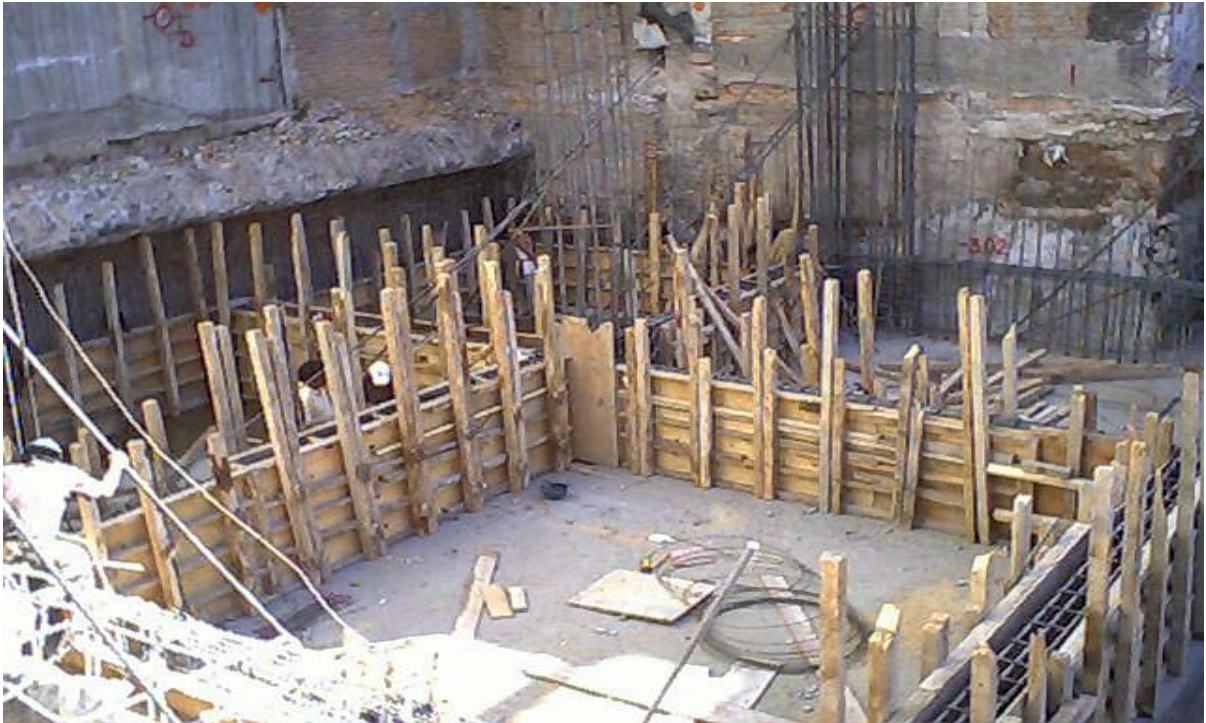
En la Fig. 3.3. Se muestra la colocación de la cimbra para el colado de contratraves
