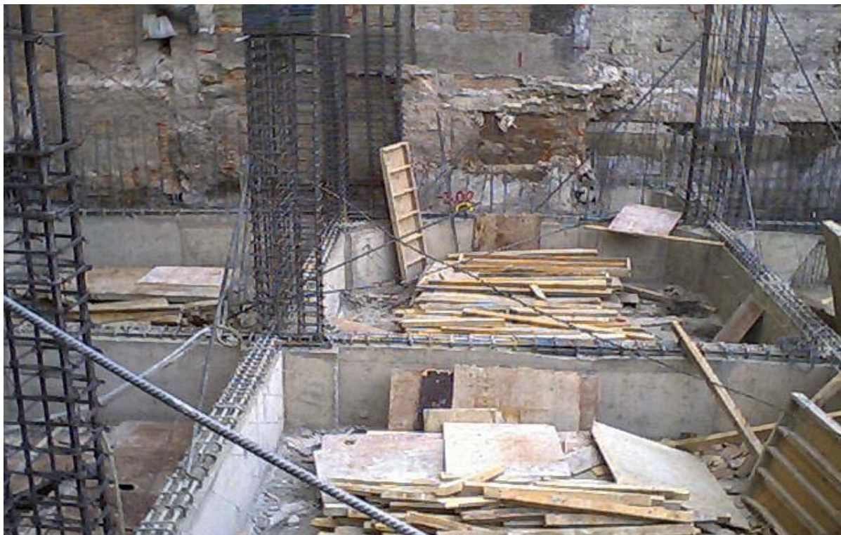
En la Fig. 3.4. Se muestra el revestimiento de acero en columnas y contratraves.
