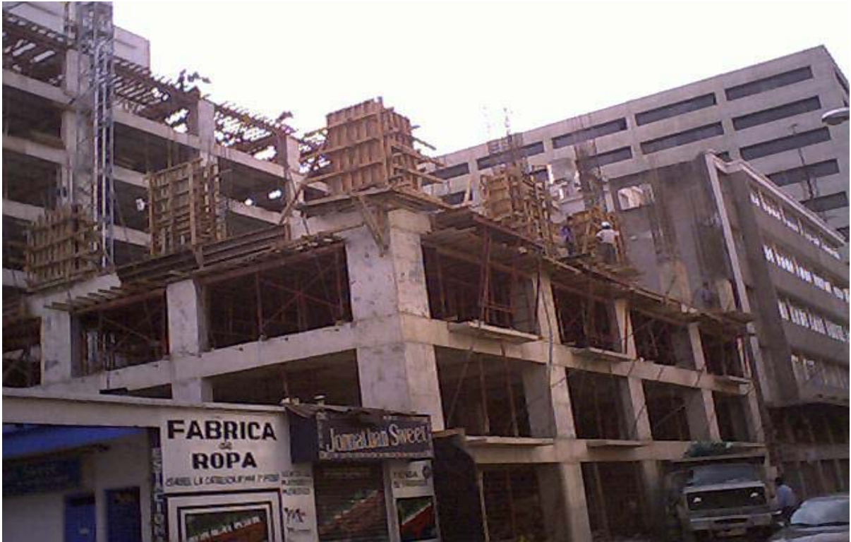
En la Fig. 3.2. Se muestra el cimbrado de columnas y trabes
