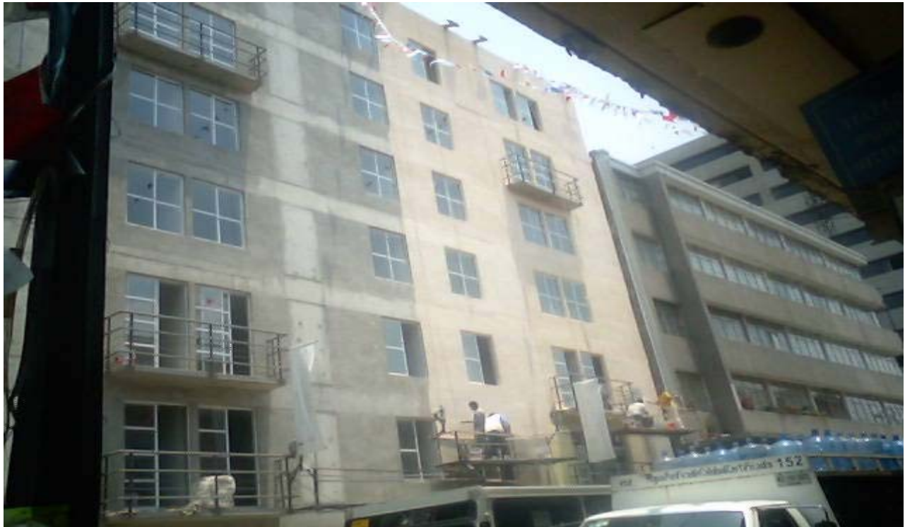
En la figura 5.8 se muestra la fachada del edificio c aplicando pasta texturizada
