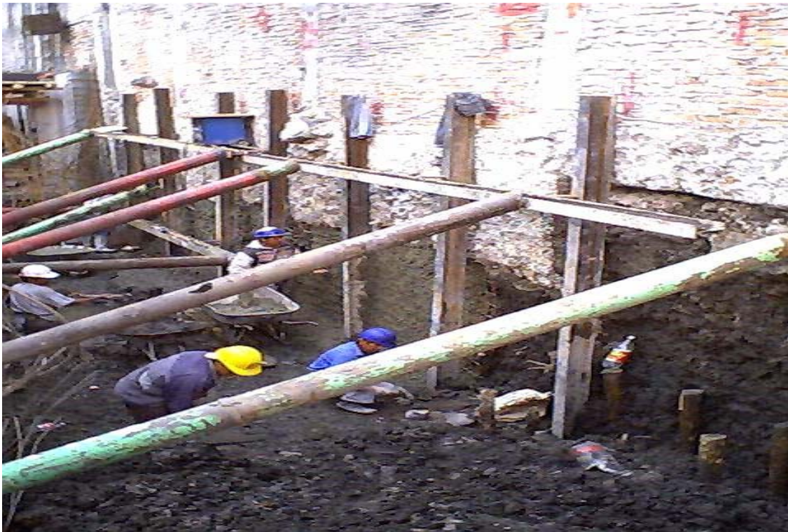
En la Fig. 2.16. Se muestra forma como se acomoda la vigueta metálica tipo IP de 6" x 24Kg/m @2.50m
