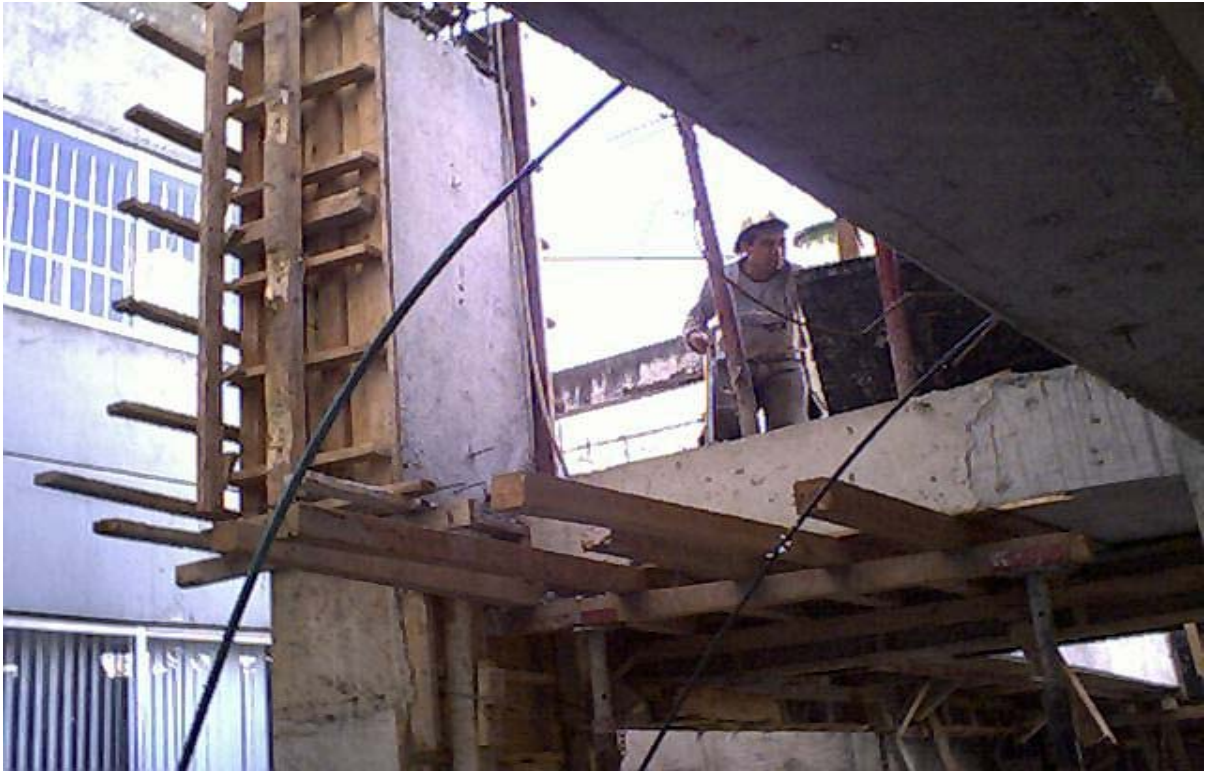
En la Fig. 3.6 Se muestra el descimbrado de la columna
