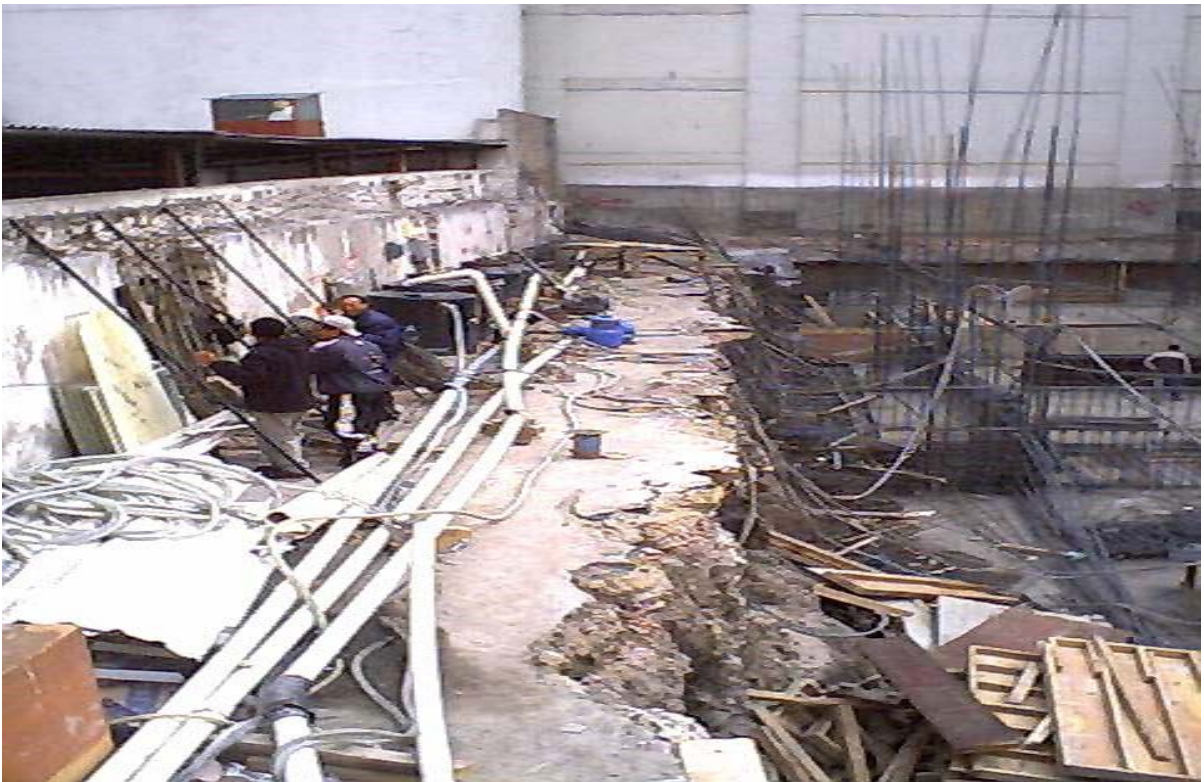
En la figura 5.6 se muestra el predio en cuestión desde el inicio de la cimentación.
