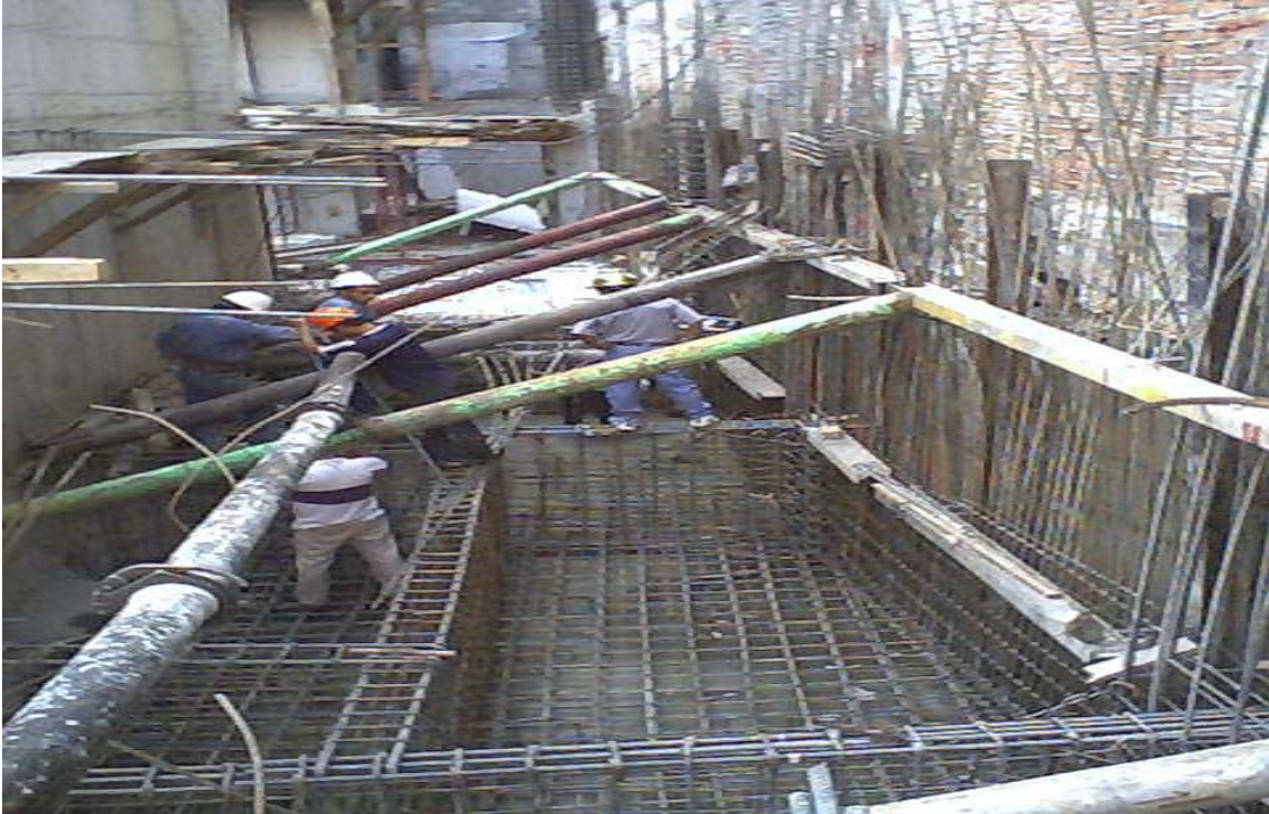
En la Fig. 2.17. Se muestra forma como se cuela la losa de cimentación y las contratraves
