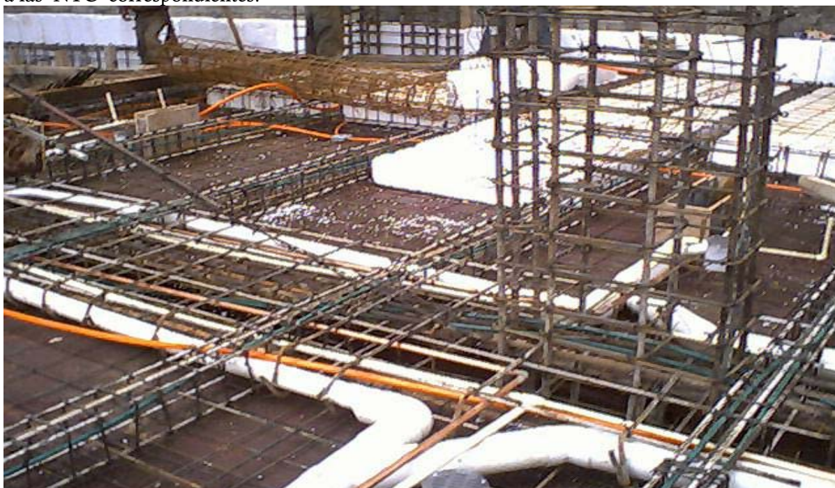
En la Fig. 3.12. Se muestra la colocación de la tubería de PVC y poliducto para las instalaciones.
