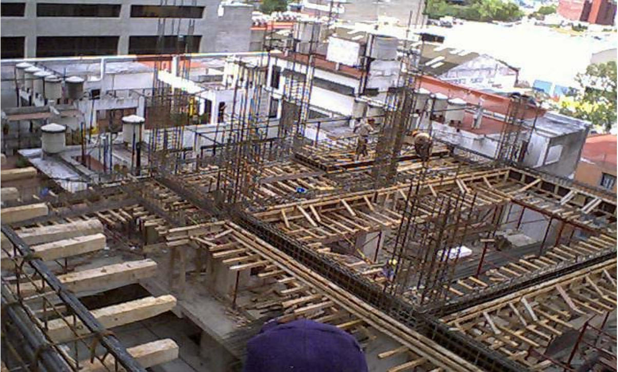
En la Fig. 3.8. Se muestra como se va colocando la cimbra para trabes.
