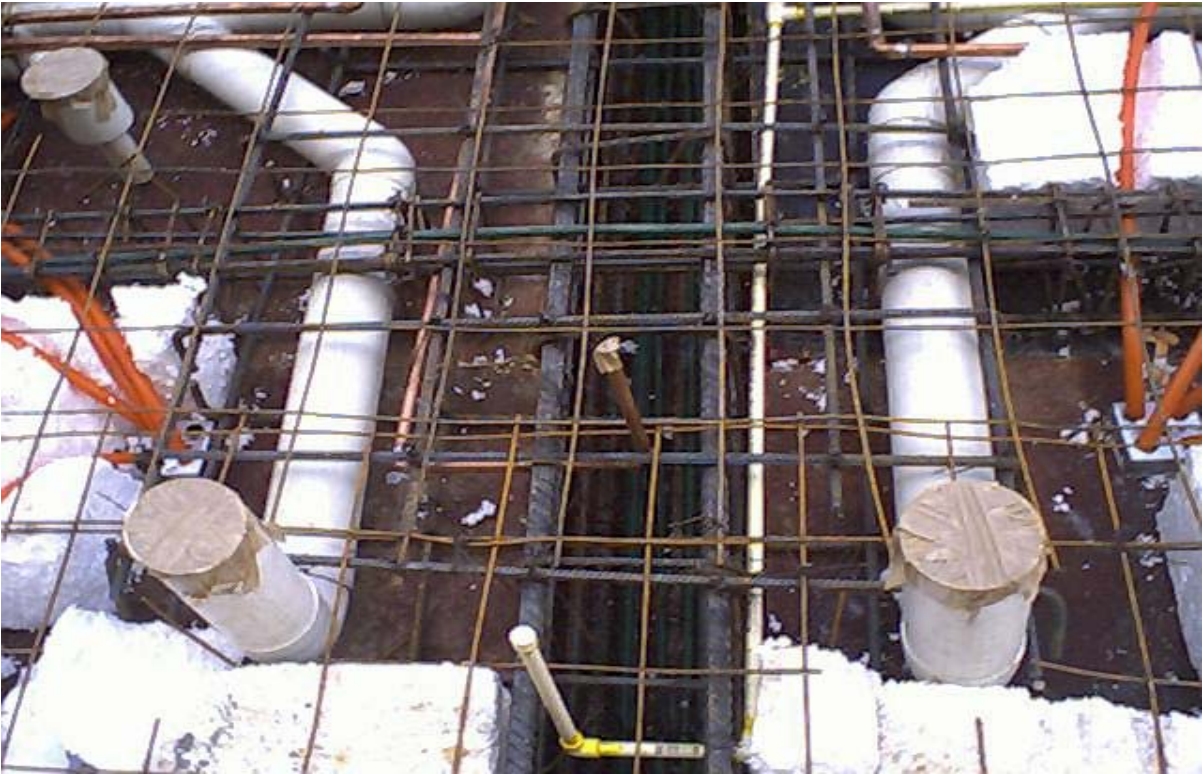
En la Fig. 3.9. Se muestra la colocación de la tubería para las instalaciones.
