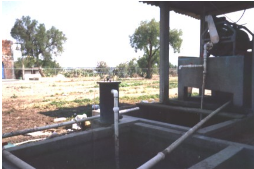
Figura 1. Tratamiento primario de aguas residuales
