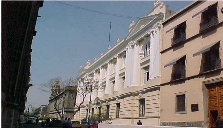
Antigua Escuela de Jurisprudencia
