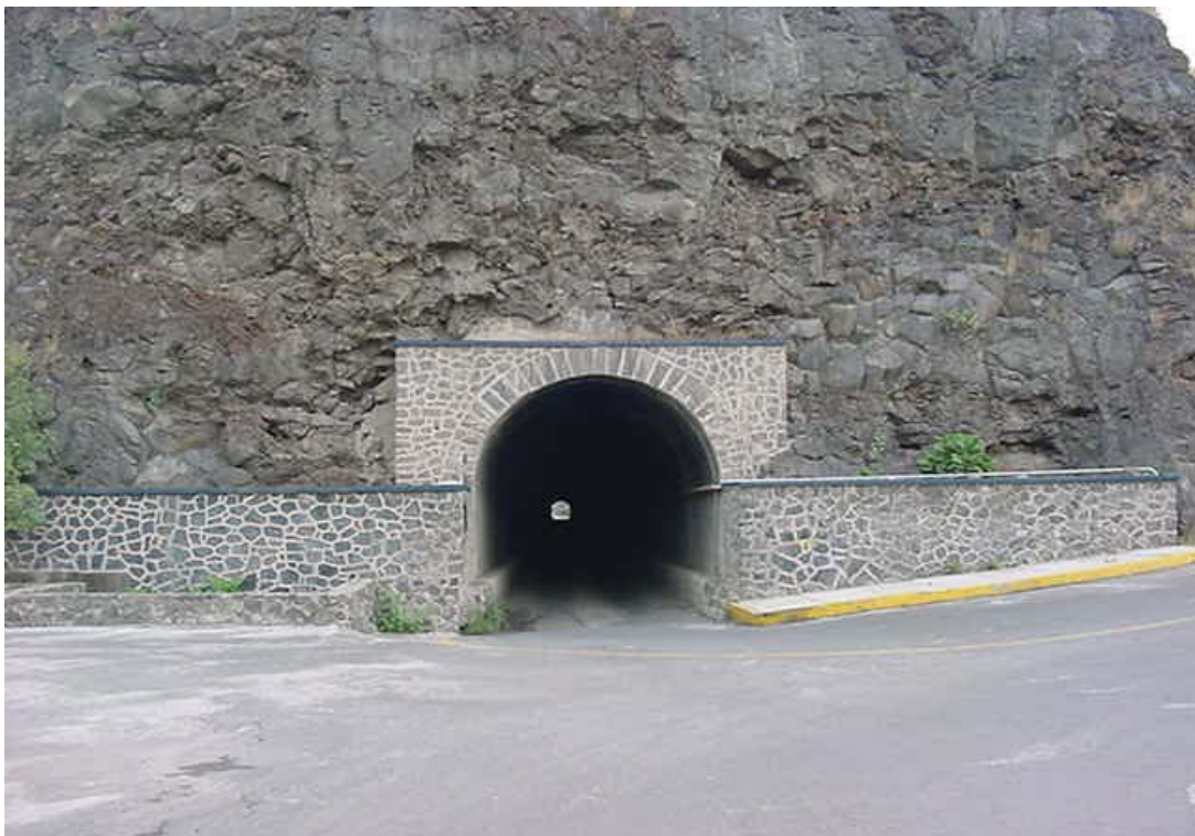
Túneles de Acceso a la Cantera Oriente
