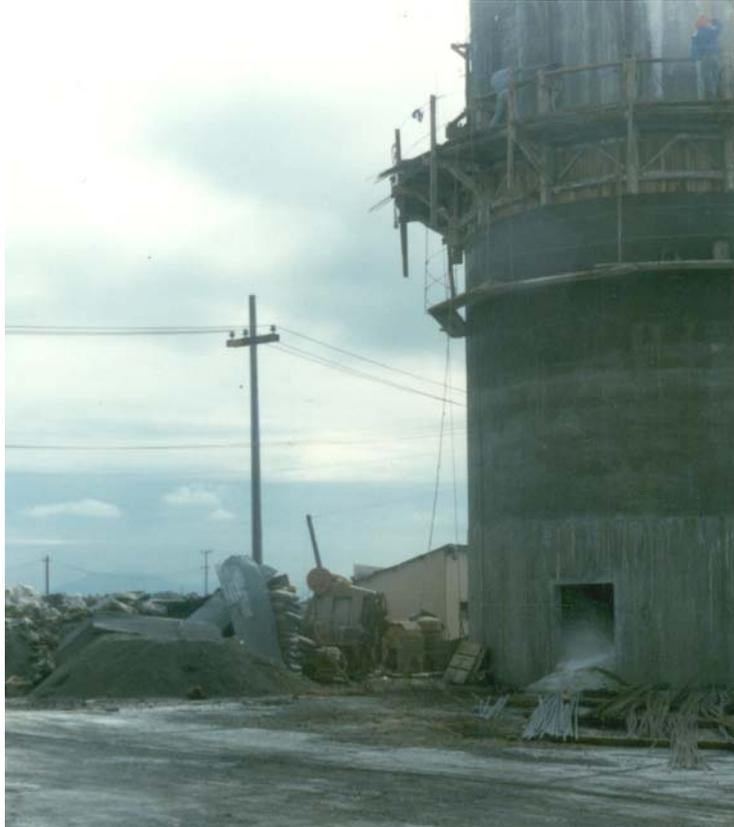
**Foto 5. Plataforma para movimiento de personal y materiales durante la reparación de silo, de almacenamiento de carbonato de sodio, por medio de cimbra deslizante. Ubicación: Ecatepec, Edo. de México. Mayo de 1987
