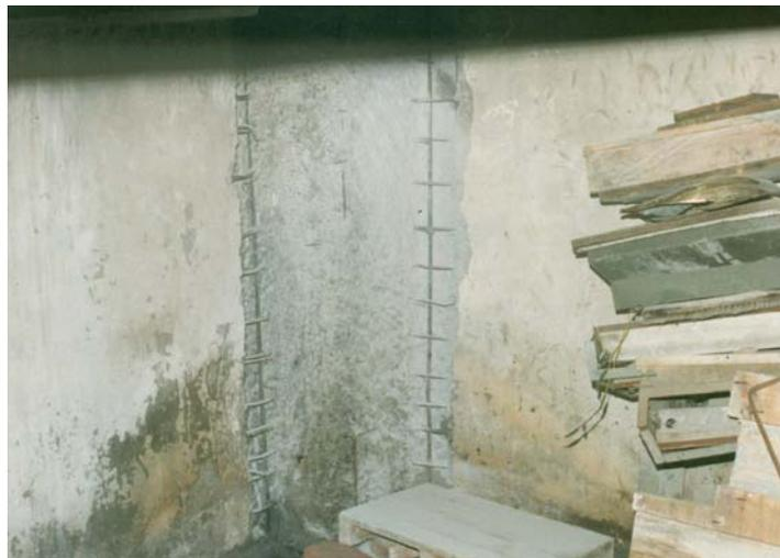
**Foto 16. Refuerzo de cimentación, edificio dañado por el sismo de septiembre de 1985. Ubicación: Av. Guerrero esquina Puente de Alvarado. Período de reparación mayo de 1986 a febrero de 1987.**
