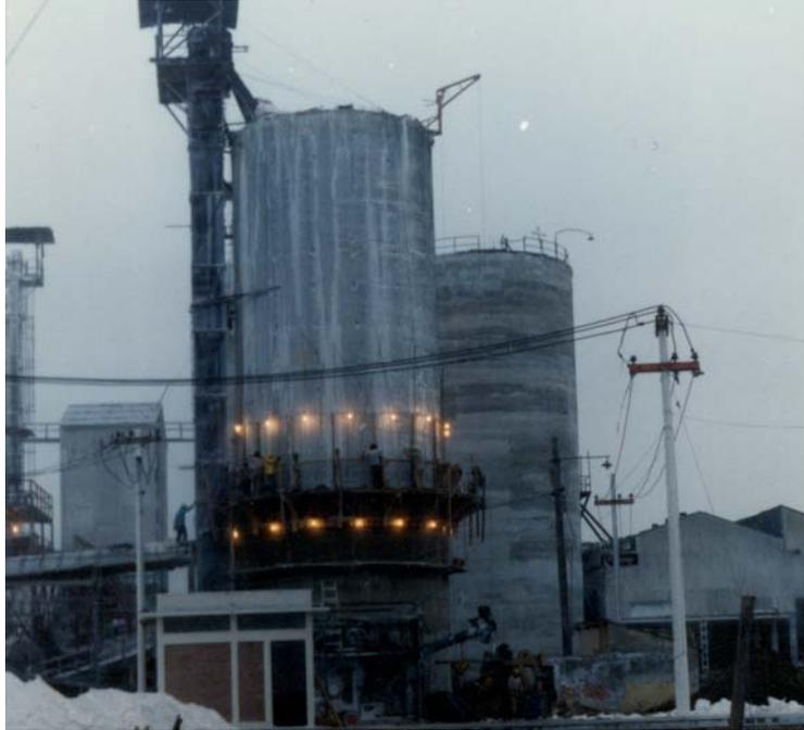
**Foto 4. Iluminación durante la reparación de silo, de almacenamiento de carbonato de sodio, por medio de cimbra deslizante. Ubicación: Ecatepec, Edo. de México. Mayo de 1987 septiembre de 1987.**
