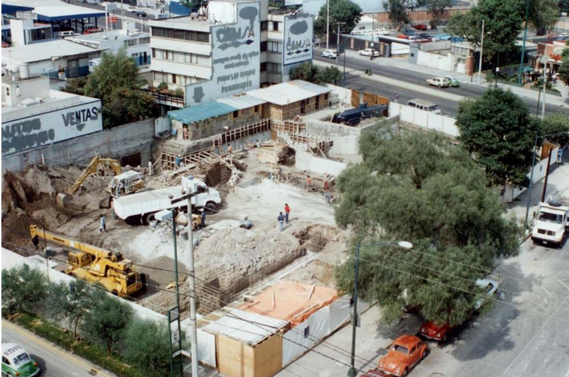
Foto 12. Excavación y construcción de cimentación de agencia automotriz. Ubicación: Av. Universidad esquina Rodríguez Saro. Período de construcción marzo a septiembre de 1994.
