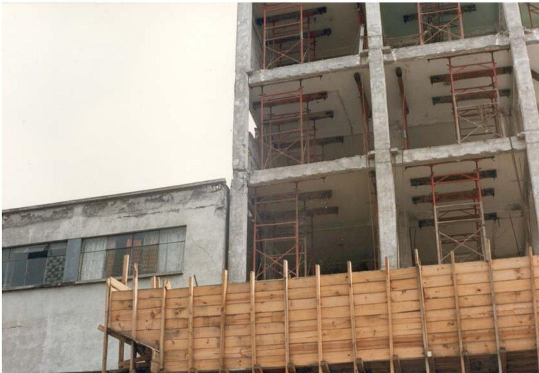
**Foto 6. Falla por impacto de dos edificaciones. Edificio dañado por el sismo de septiembre de 1985. Ubicación: Av. Guerrero esquina Puente de Alvarado. Período de reparación mayo de 1986 a febrero de 1987.**
