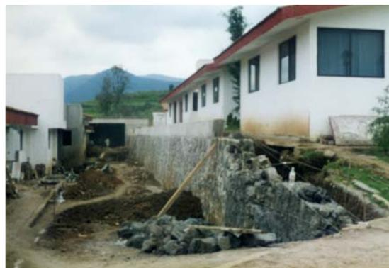
Foto 13. Construcción de muro de mampostería. Ubicación: Huixquilucan, Edo. de México. Período de mayo a diciembre de 1996.
