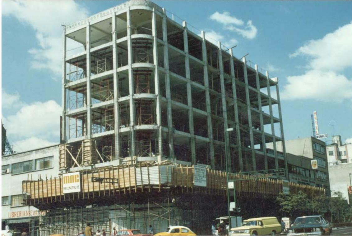
**Foto 3. Tapial de paso cubierto y apuntalamiento de losas. Edificio dañado por el sismo de septiembre de 1985.**
