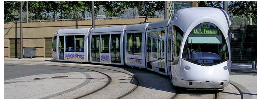
LRV de Lyon, Francia (operación mediante catenaria y pantógrafo)
