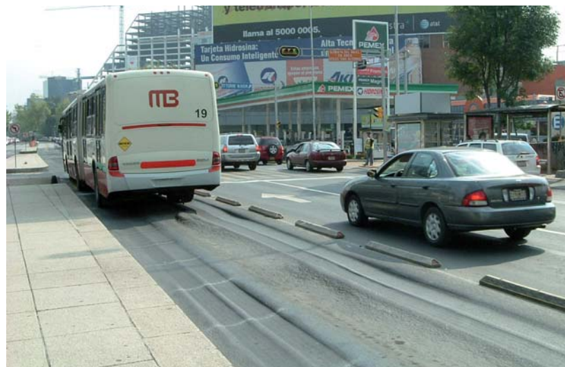
Carril confinado del metrobús
