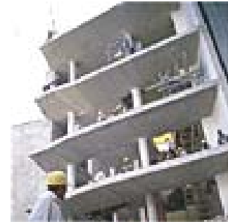
REHABILITACION DEL EDIFICIO.
