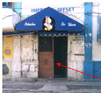
A. FACHADA EXTERIOR .ACABADO LISO COLOR GRISACEO.
