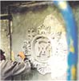
RESTITUCION DE ELEMENTOS DAÑADOS.
