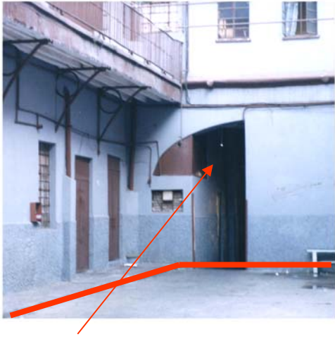
D. ACCESO DESDE EL INTERIOR. ARCO DE MEDIO PUNTO.
