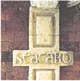
RESTITUCION DE ELEMENTOS DAÑADOS.
