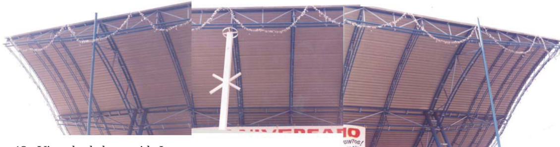
Foto 12. Vista desde la avenida Izazaga
