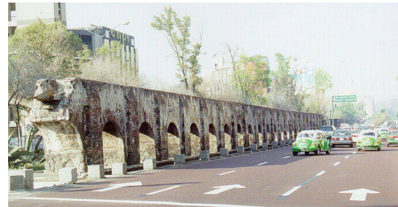
Vista de los restos del acueducto ubicado en Av. Chapultepec
