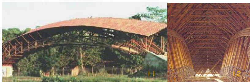
Puente peatonal Jenny Garzón, Bogotá Colombia.
