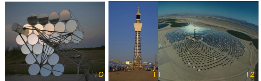
Platos parabólicos, planta de recepción central
