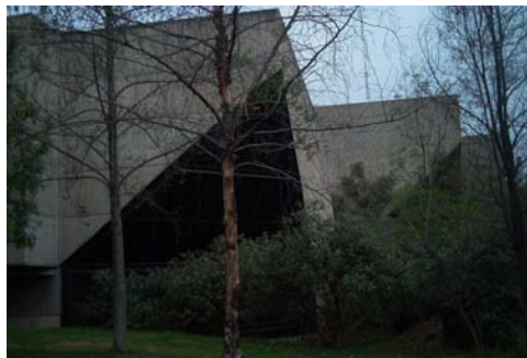
Fachada Este, básicamente se repite con las demás.
