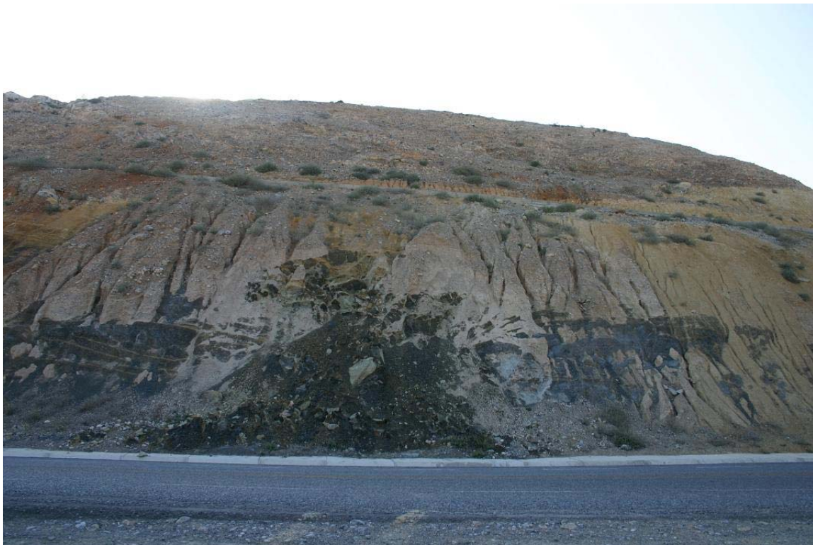
Fotografía 13. Formación de suelos por lavado, quedando arenas con poco cementante.
