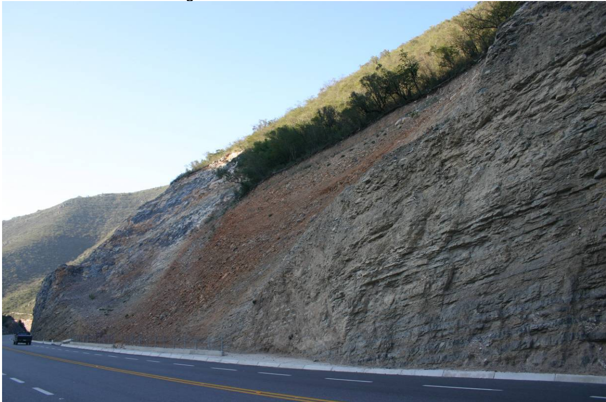
Fotografías de la carretera Rumbo Nuevo
