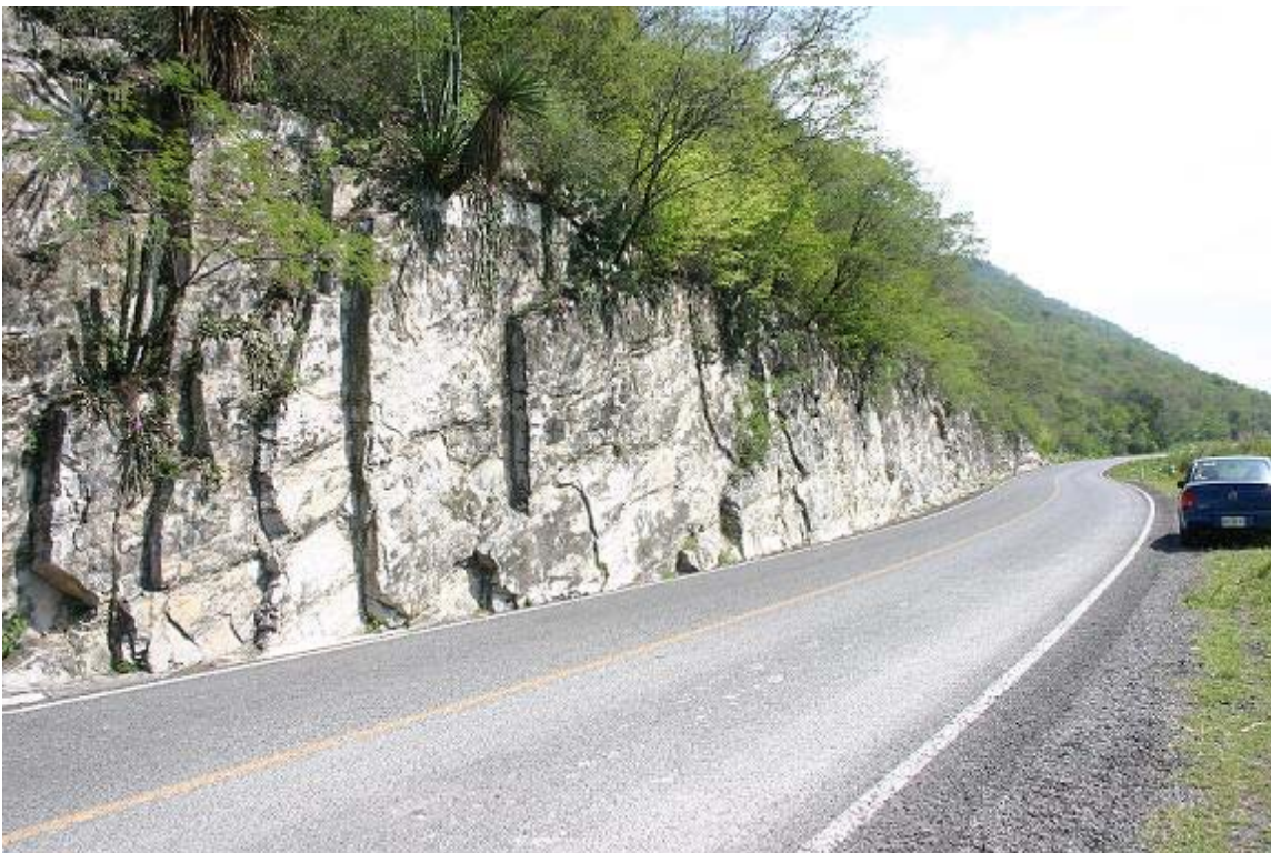
Fotografía 2. Asentamiento de material vegetal en juntas de las rocas con echado poco propicio para la estabilidad.
