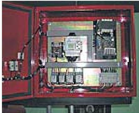
**Figura. 4.7 Tablero de control alternador y simultaneador.**
