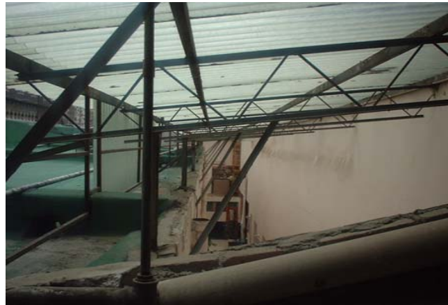
ARMADURA DE VARILLA ¼ DE DIÁMETRO
