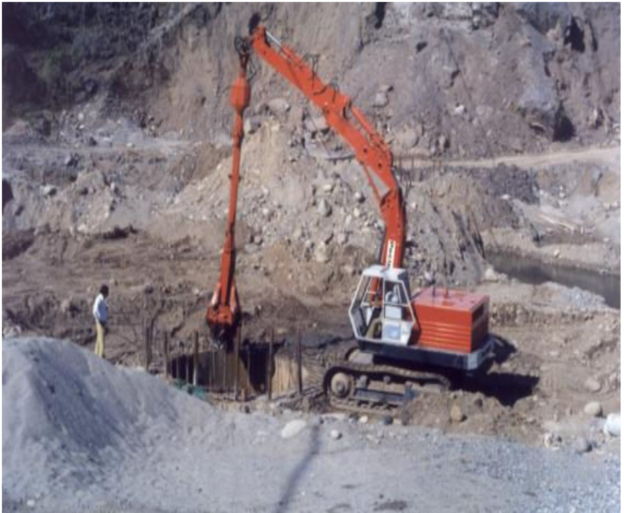
Fotos 5.5 Cajón de cimentación Puente Ixtapa
