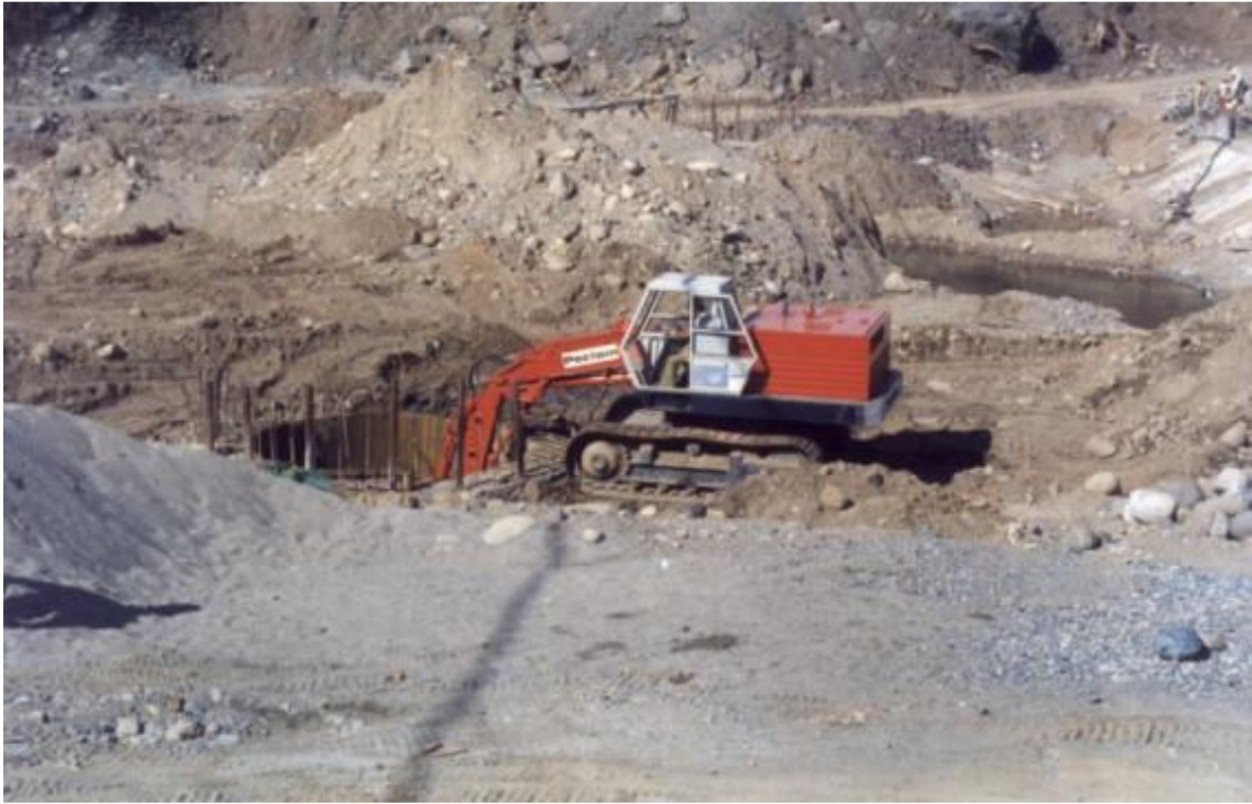
Foto 5.6 Extracción de material del fondo del cajón para el Puente Ixtapa
