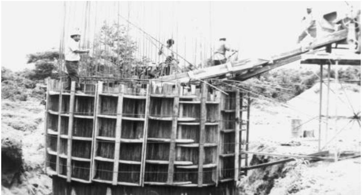
Foto 5.3 Puente Espuelas II
