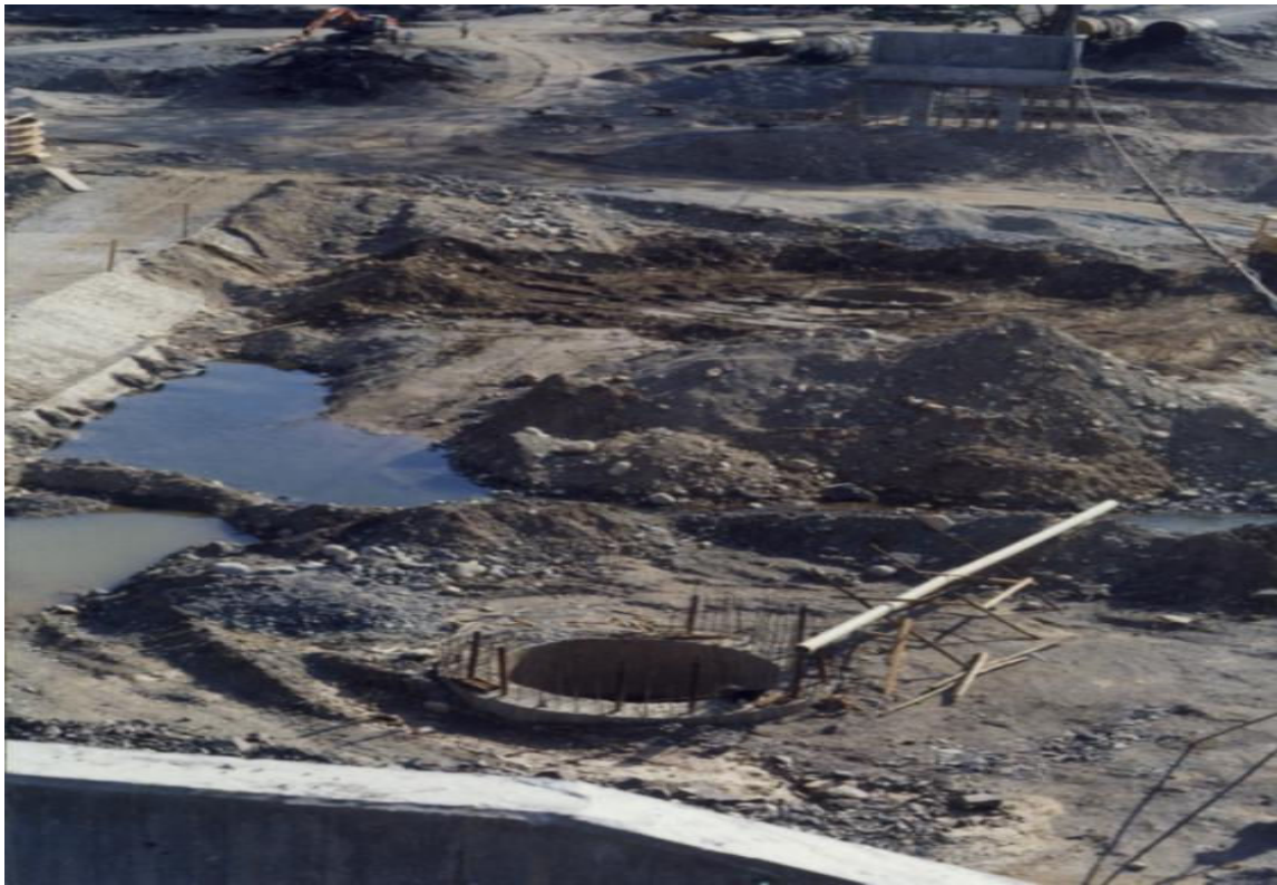
Foto 5.7 Panorámica del proyecto de cimentación del Puente Ixtapa
