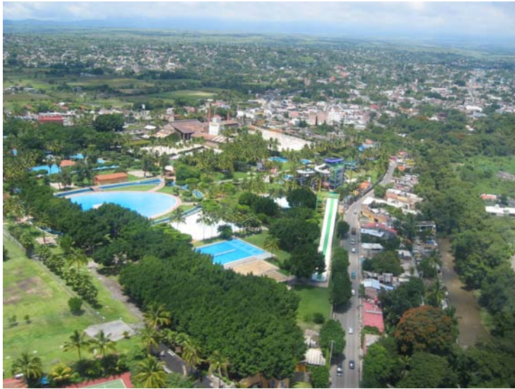
7. Vista del balneario.
