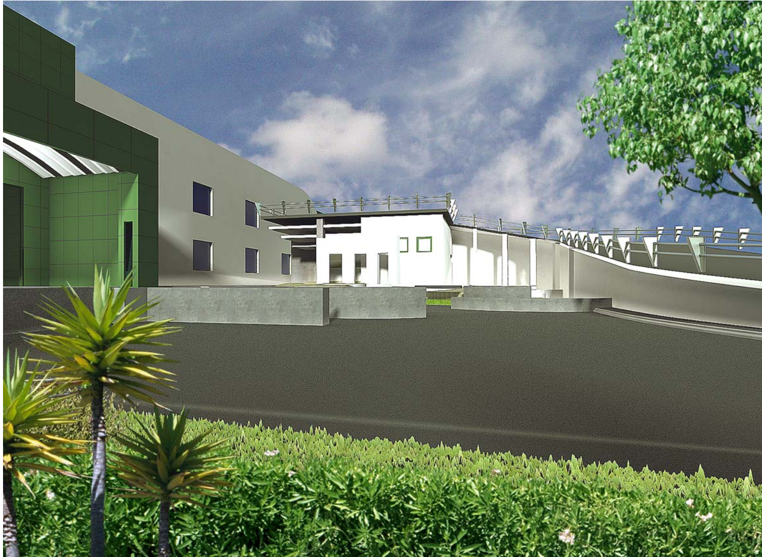
Nave de separación, baños, rampa y plataforma de transferencia. El cuerpo principal de la nave de separación tiene un manejo rítmico de los vanos con un predominio del macizo, que es una expresión propia del estilo contemporáneo, como también lo es el énfasis que se da en los accesos del baño, comedor y administración a través de planos seriados horizontales gradualmente reducidos de tamaño. La rampa acentúa el sentido orgánico del diseño en esta zona.
