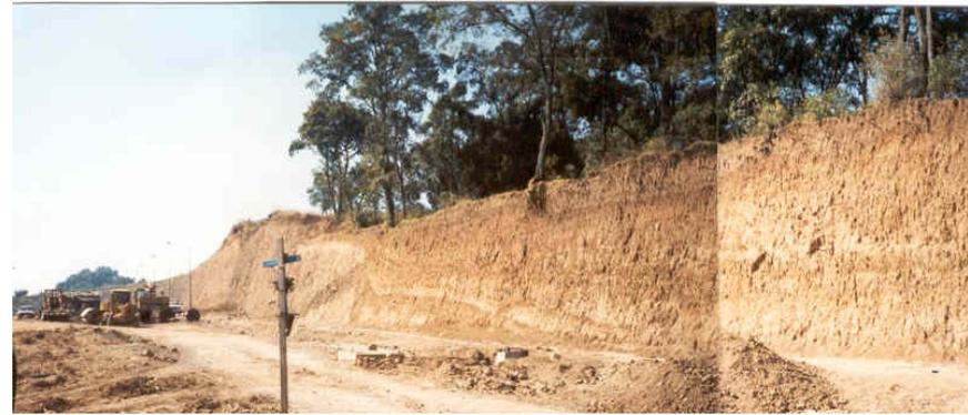
FOTO 6.- AV. PROLONGACIÓN VASCO DE QUIROGA VISTA DEL CORTE DEL TERRENO DE TEPETATE
