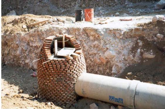
FOTO 17.- CONSTRUCCIÓN DE POZOS DE DRENAJE
