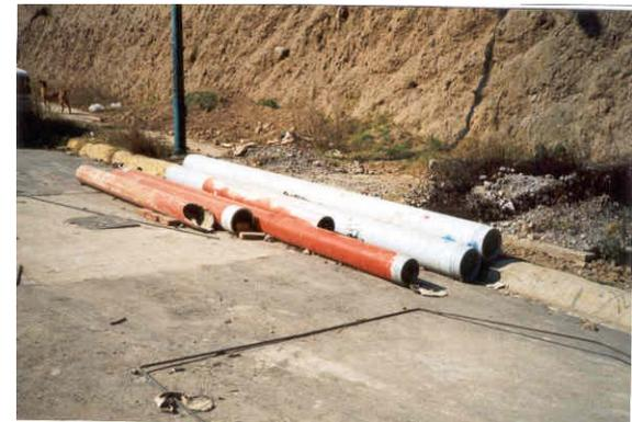
FOTO 16.- TUBERÍA DE AGUA POTABLE Y PLUVIAL
