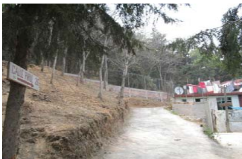
Estado actual, talud y barda existentes
