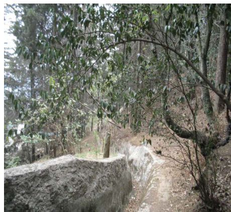
Canal de agua pluvial existente
