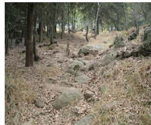
Estado actual, erosión hídrica natural existente
