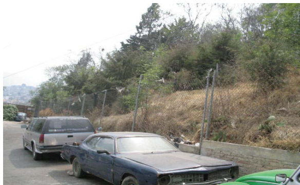
Fotos del estado actual del Cerro del Judío, barda perimetral
