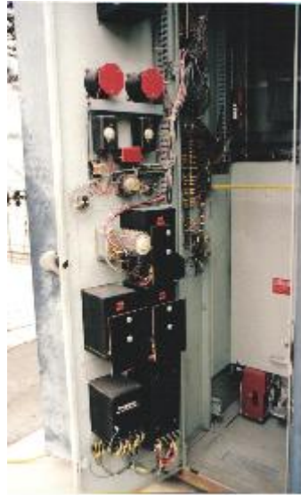
Fig. 4.3 Alambrado requerido para los relevadores tradicionales
