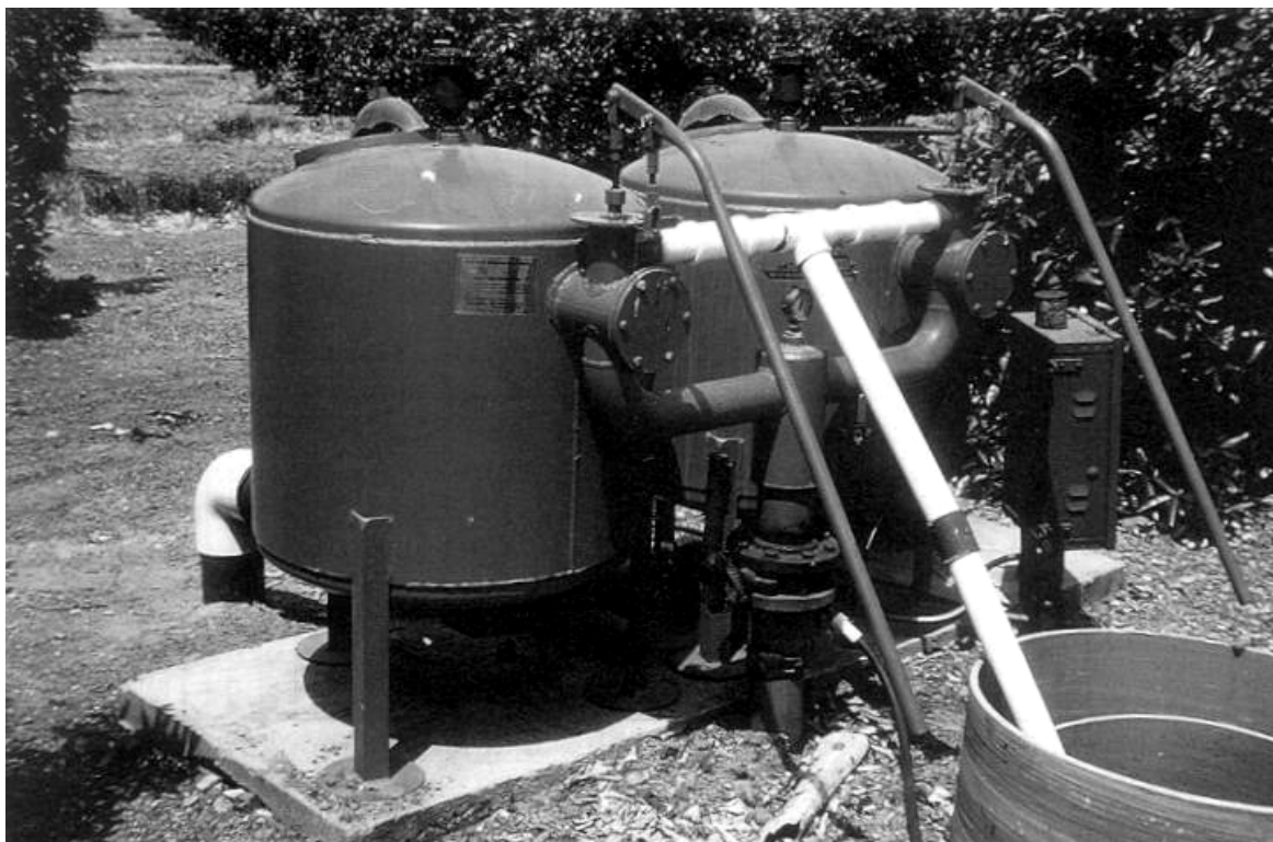
Figura 2.4 Imagen de filtro de arena 41
