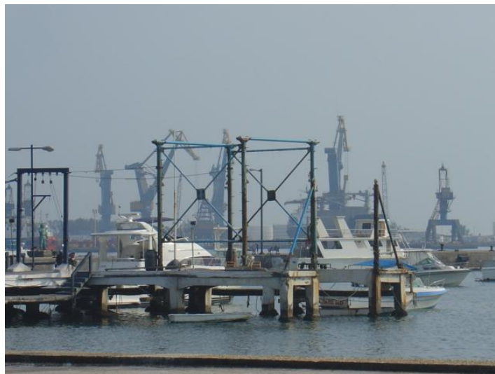
Foto 2.4: En esta foto podemos apreciar parte del muelle de este club y la zona de grúas; la cual ya se encuentra abandonada.
