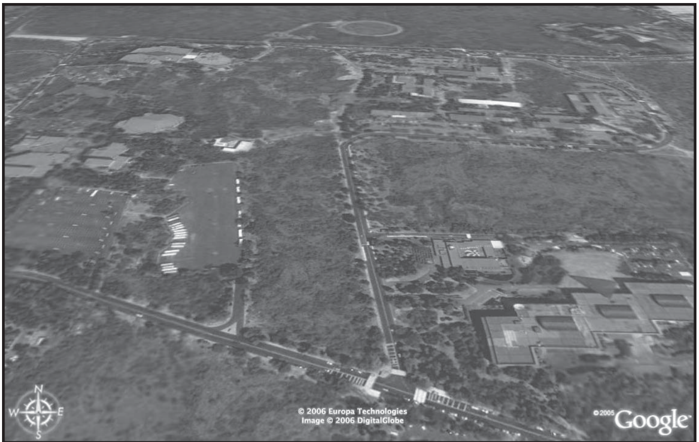
FOTO AEREA PERSPECTIVADA, CENTRO CULTURAL UNIVERSITARIO, TERRENO ESCOGIDO Y UNIVERSUM
