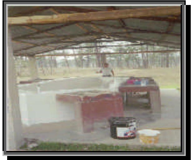
Saneamiento y restauración de estanque
