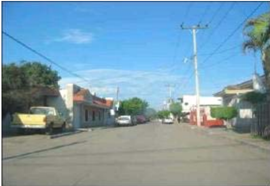
VISTA DE AVENIDA PAVIMENTADA, CON GUARNICIONES Y BANQUETAS DE CONCRETO
