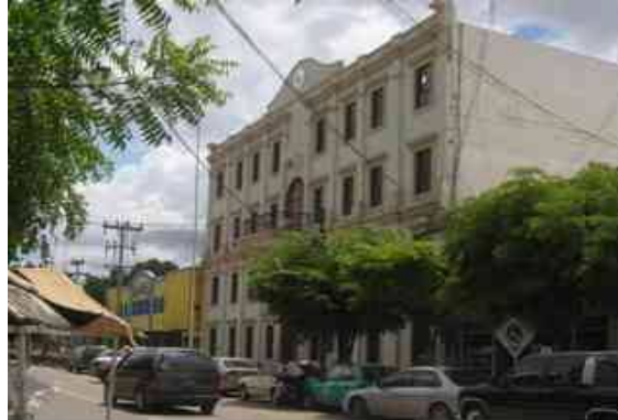
VISTA DE EDIFICIO TIPO COLONIAL (PALACIO MUNICIPAL)
