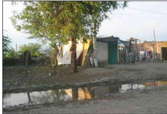
CONSTRUCCION TIPO PRECARIA Y VIALIDAD DE TERRACERIA
