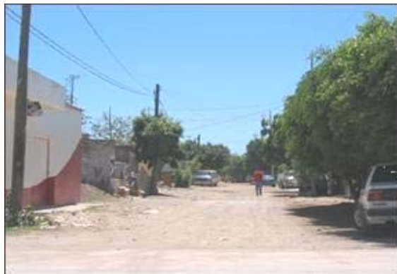
VISTA DE VIALIDAD SIN PAVIMENTAR
